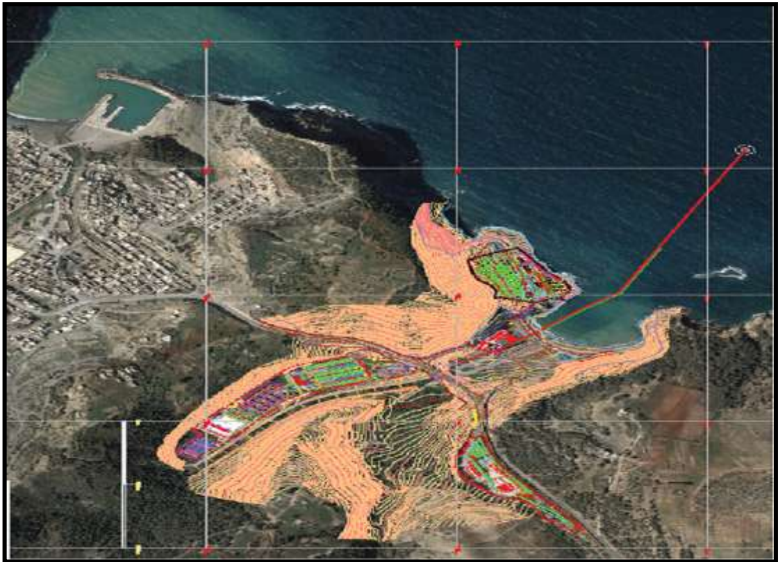
Figure III. 2 : Vue satellitaire du site de la station de dessalement.
