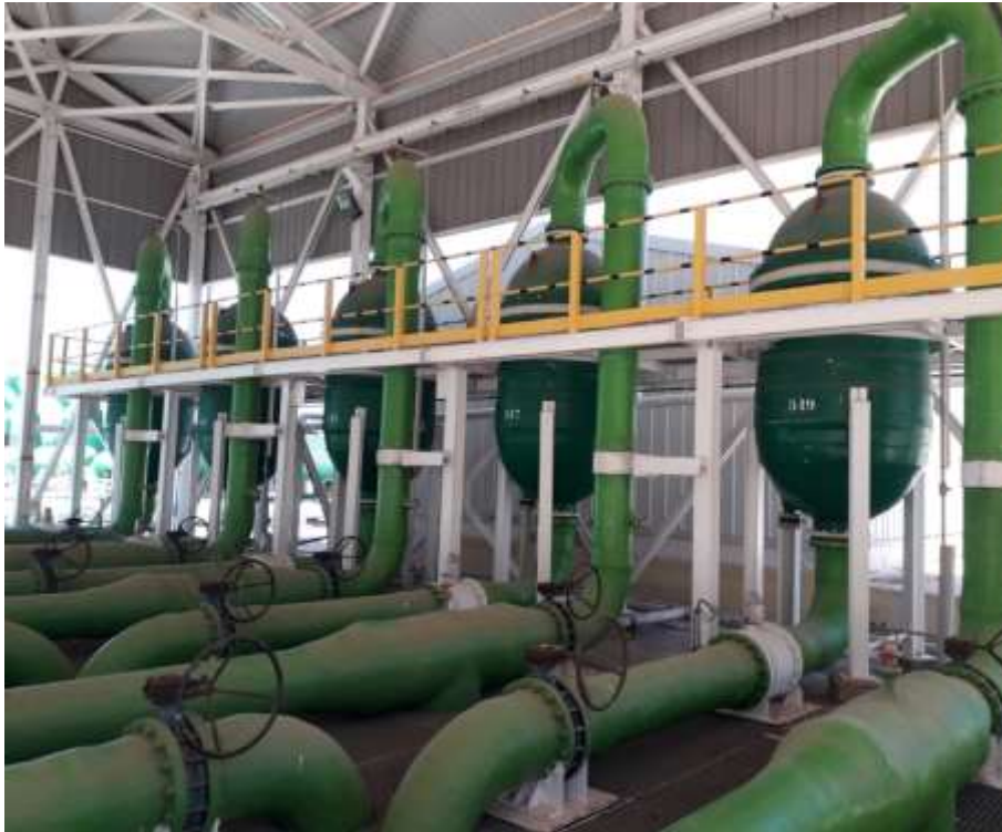
Figure III. 5 : Filtres à cartouches.
