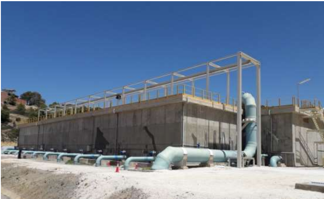
Figure III. 13 : Photo du réservoir de stockage de l'eau produite.
