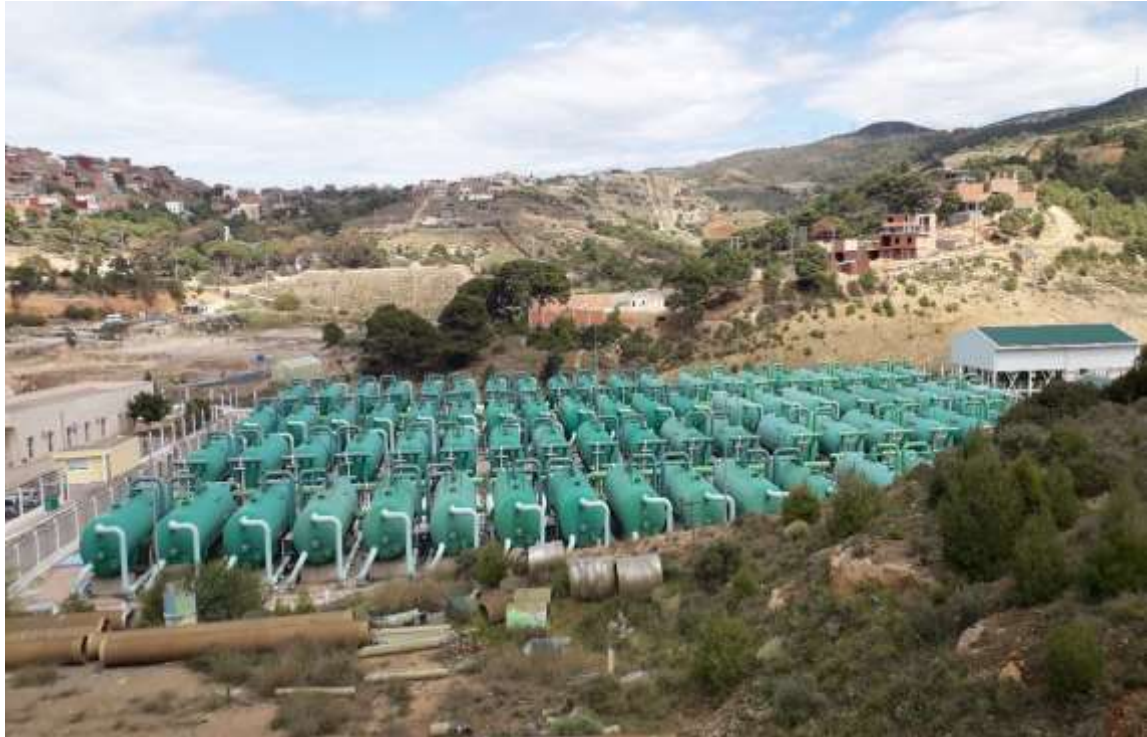
Figure III. 4 : Filtres à sable et anthracite.
