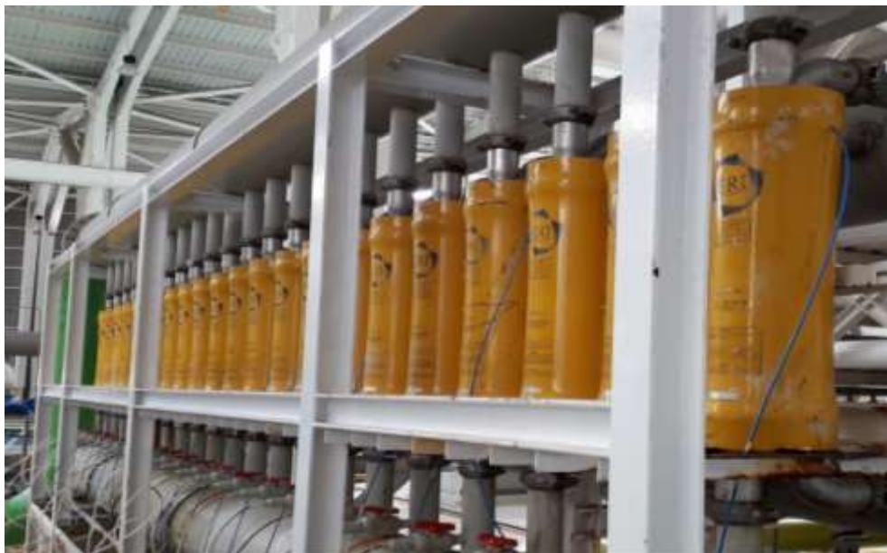
Figure III. 12 : Les ERIS (système de récupération de pression).
