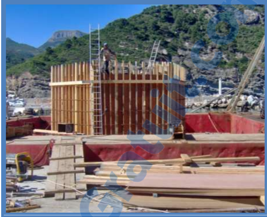
Figure III. 3 : Tour de captage d'eau en cours de construction [46].
