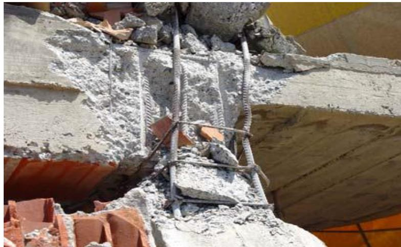
Figure1.4- Endommagement d'un nœud a raison de l'insuffisance des armatures transversales(Boumerdes, 2003) [6].
