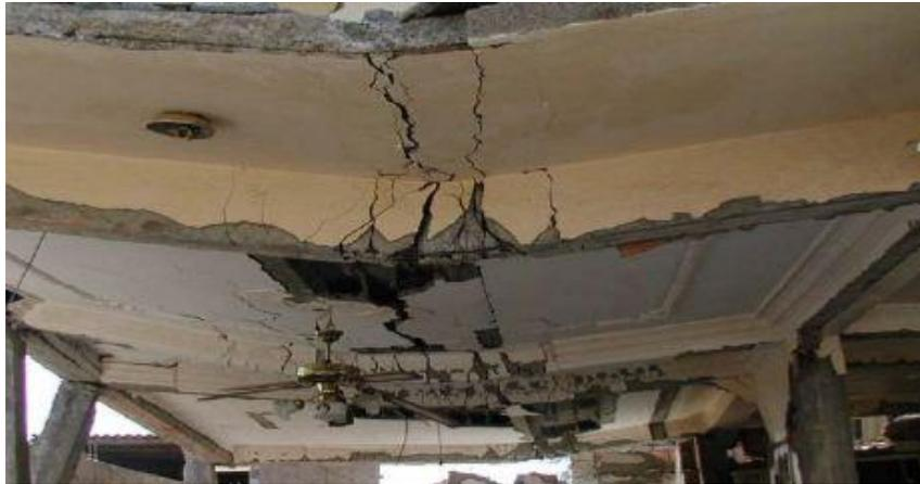
Figure1.5- Endommagement d'une poutre par flexion
