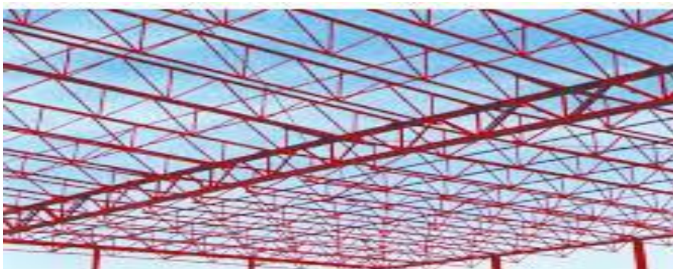
Figure I.4 : poutres en treillis
