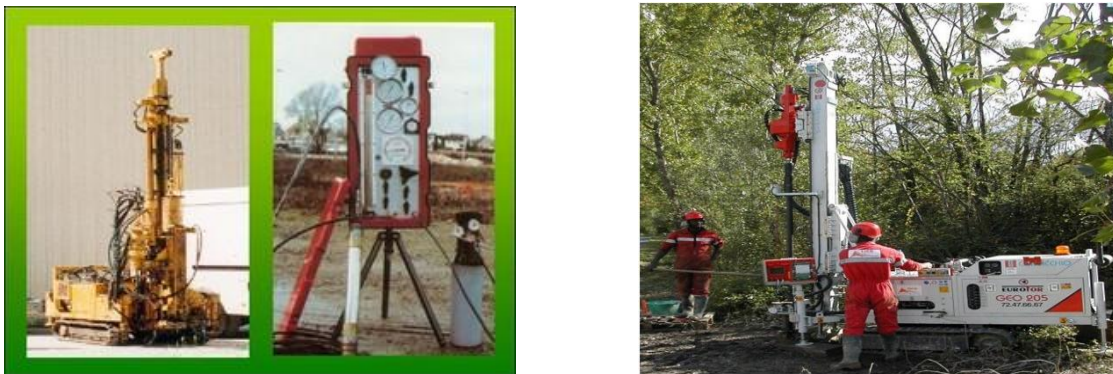
Photo I.1 : les essais in-situ en géotechnique (CDCA, 2012)
