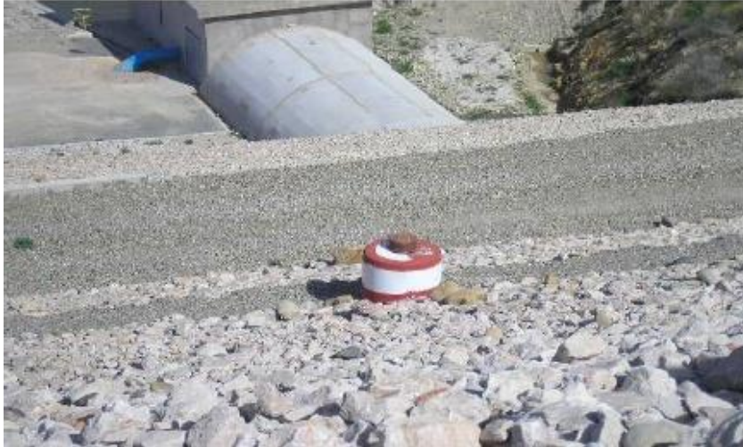
Photo III.1 : Borne sur talus aval servant aux mesures des déplacements Barrage Sidi Abdelli, wilaya de Tlemcen (ROUISSAT, 2007)
