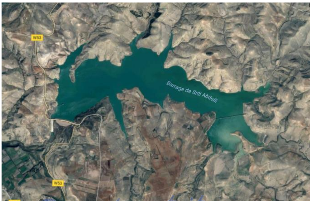
Photo IV.1: Vue par satellite « barrage Sidi Abdelli »
