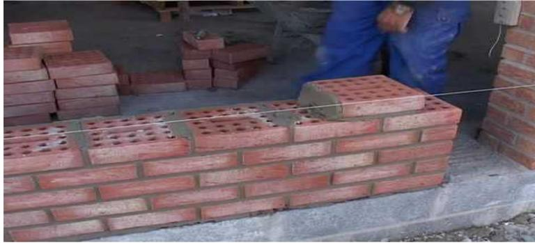
Figure 1.4: Maçonnerie en briques perforées [mur.ooreka.fr]
