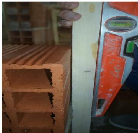
Figure 3.26: Vérifier la planéité et la verticalité entre les deux lignes horizontales par le biais d'une règle et du niveau à bulle.
