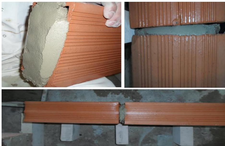
Figure 3.23: Préparation du joint vertical (photo prise par les auteurs).
