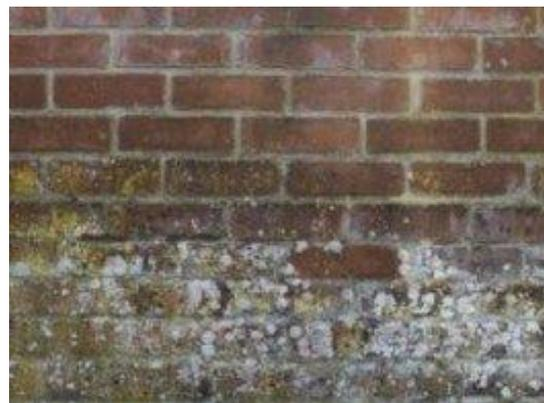
Figure 1.15: Moisissure sur un mur extérieur
