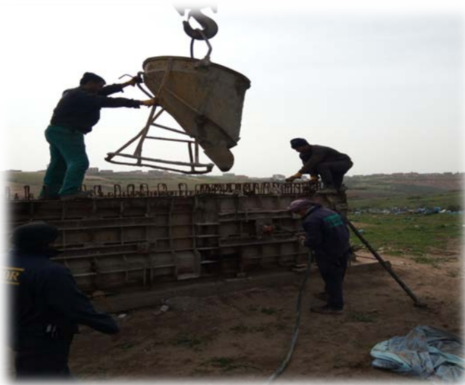
Photo 52 : Mode opératoire de bétonnage des poutres
