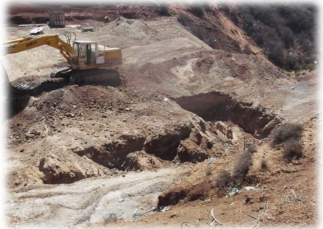
Photo 6 : Travaux de terrassement « Déblai pour fouilles »
