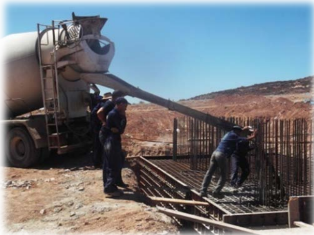
Photo 12 : Bétonnage de la Semelle.
