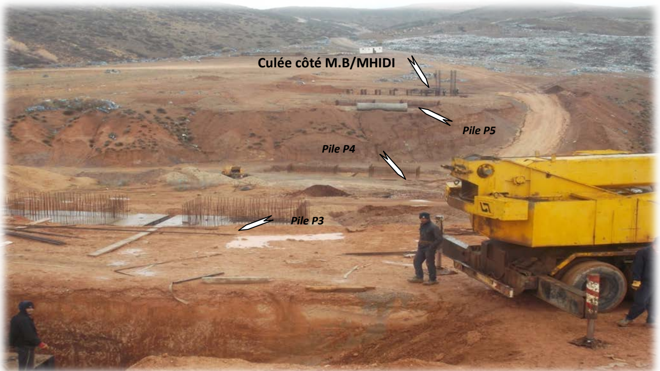
Photo 2 : Vue d'ensemble de l'ouvrage.
