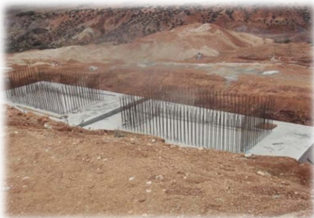
Photo 14 : Semelle de la pile achevée.
