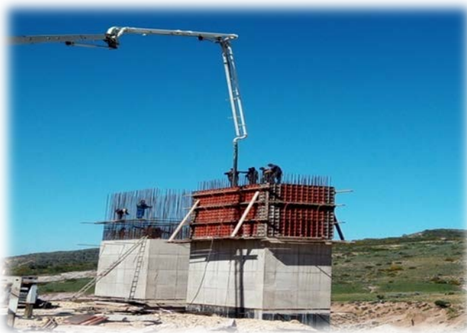
Photo 22 : Mode opératoire de bétonnage des piles
