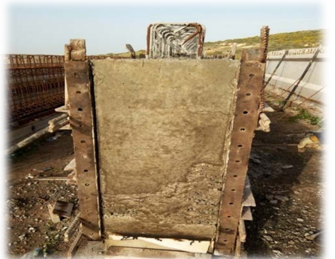
Photo 51 : Décoffrage des poutres en béton armé
