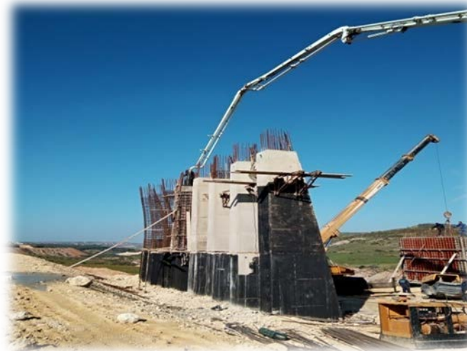
Photo 35 : Bétonnage des murs contreforts culée 1 levée
