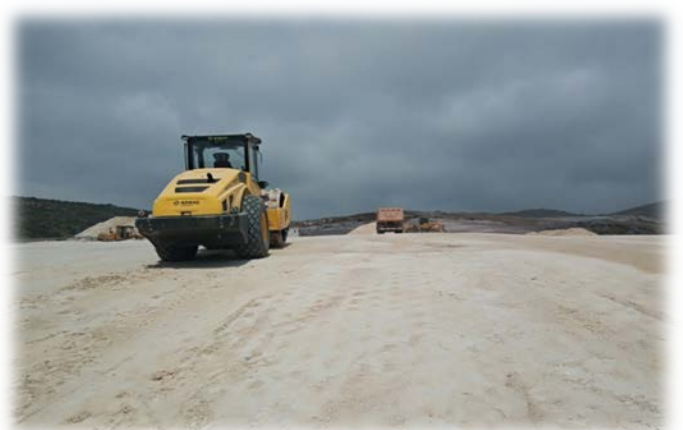
Photo10 : Travaux de terrassement « remblais »
