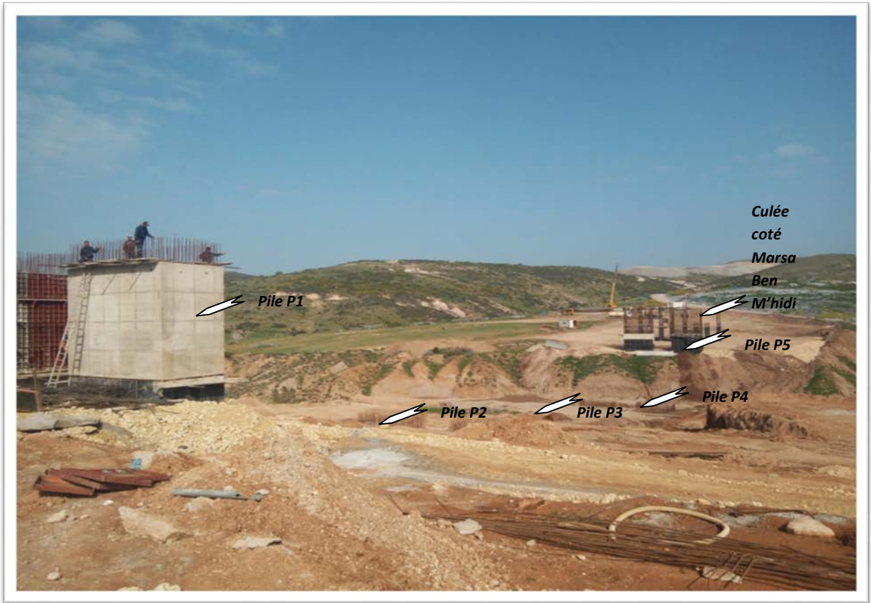
Photo 3 : Vue d'ensemble de l'ouvrage.
