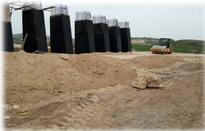
Photo 7 : Travaux de terrassement « remblais »
