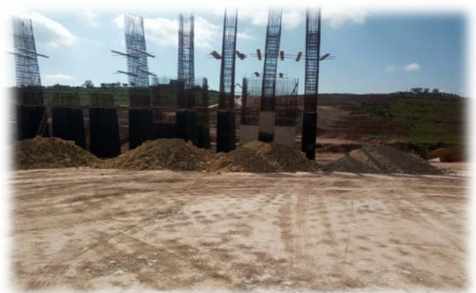
Photo 8 : Travaux de terrassement « remblais »
