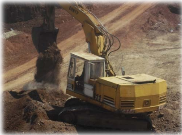
Photo 5 : Travaux de terrassement « Déblai pour fouilles »
