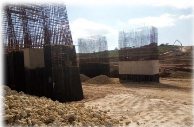
Photo9 : Travaux de terrassement « remblais »
