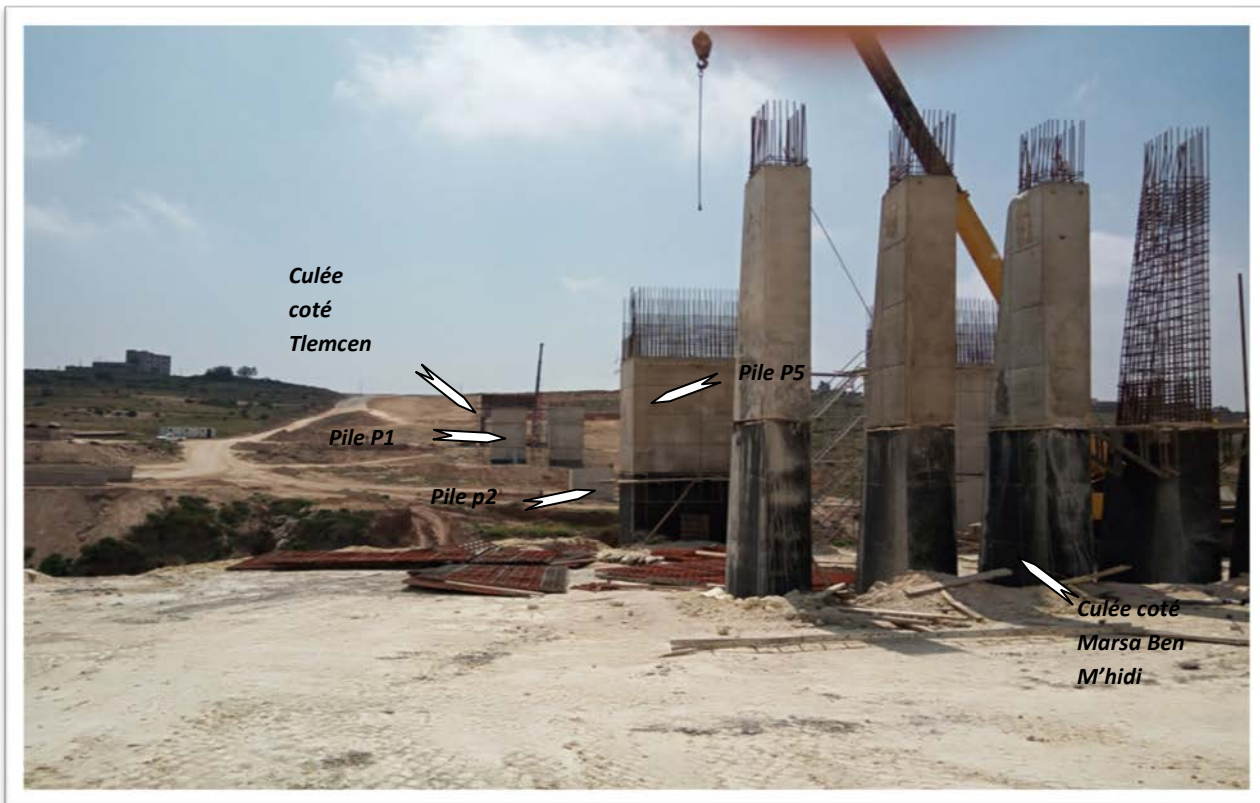
Photo 4 : Vue d'ensemble de l'ouvrage.
