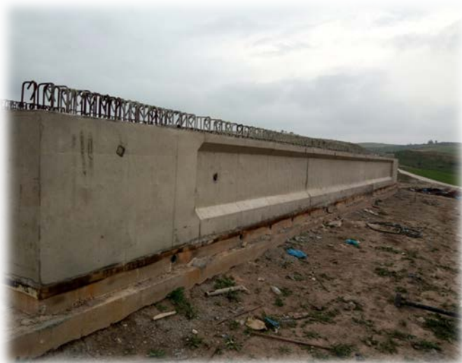
Photo 50 : Poutre en béton armé
