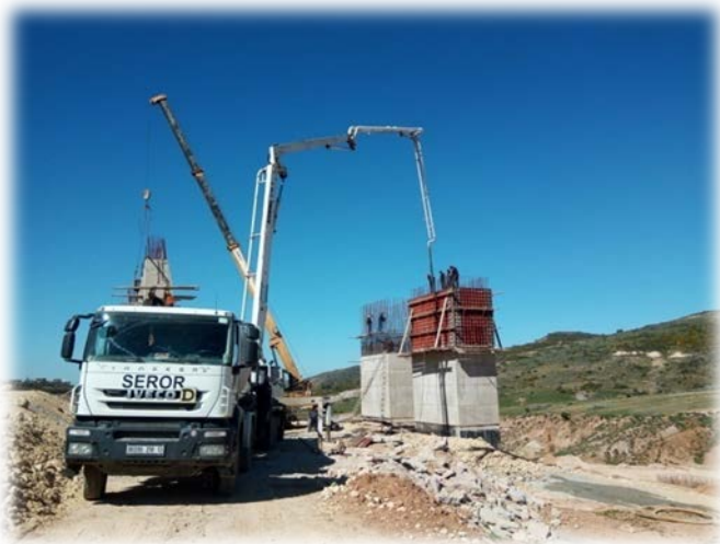
Photo 24 : Mode opératoire de bétonnage des piles
