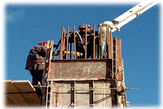
Photo 33 : Bétonnage des murs contreforts culée 2
