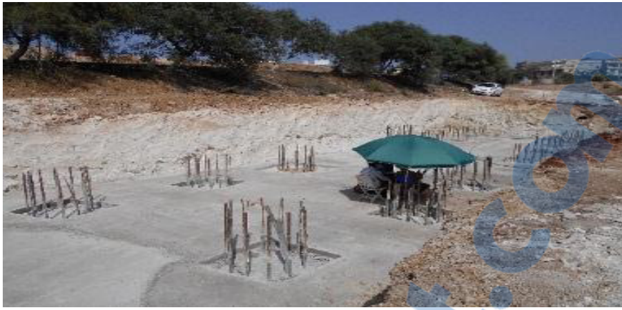
Photo 06 : Essai d'auscultation
