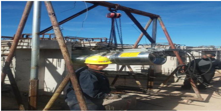
Photo 28 : Mise en tension des câbles de précontrainte
