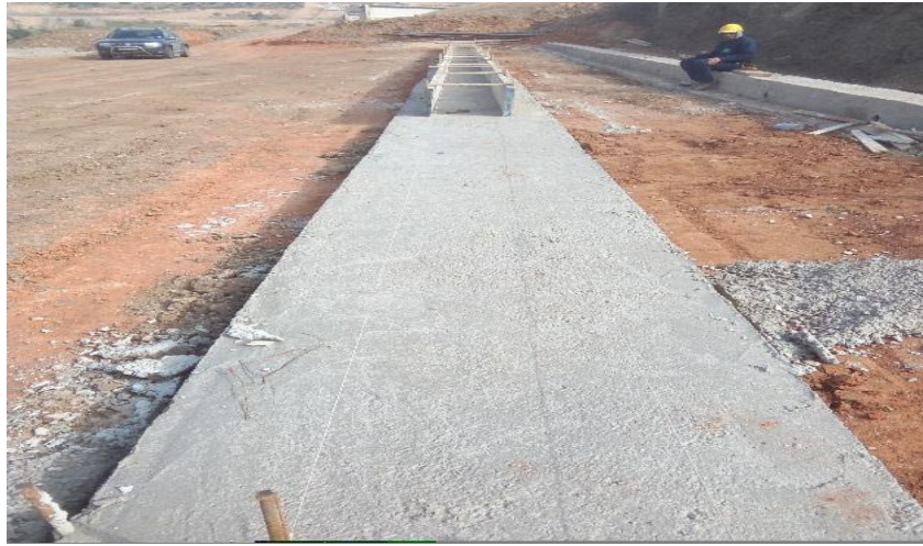
Photo 19 : Pose du béton de propreté
