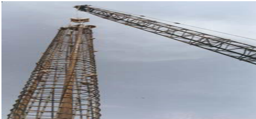
Photo 04 : Mise en place du ferrailage
