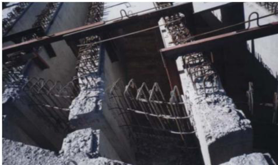
Photo 29 : Ferrailage des entretoises
