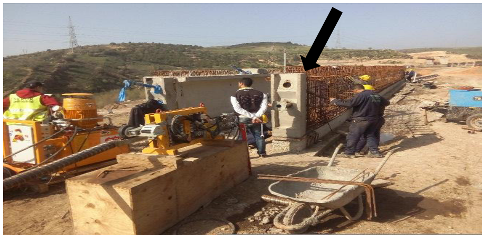
Photo 23 : Pose des abouts de poutre et passage des gaines
