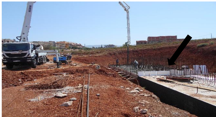
Photo 09 : Coulage de la semelle
