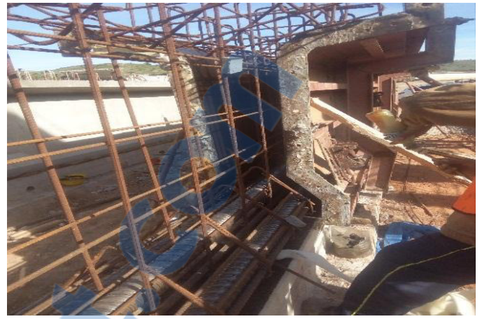
Photo 25 : Pose du coffrage de la poutre précontrainte
