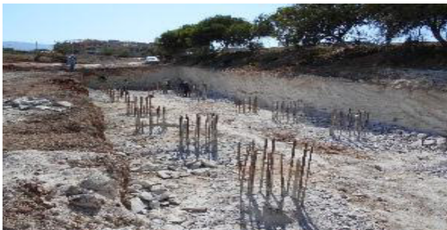
Photo 05 : le recepage des pieux
