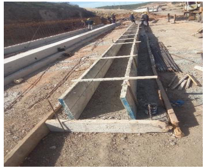
Photo 20 : Réalisation du socle de poutre
