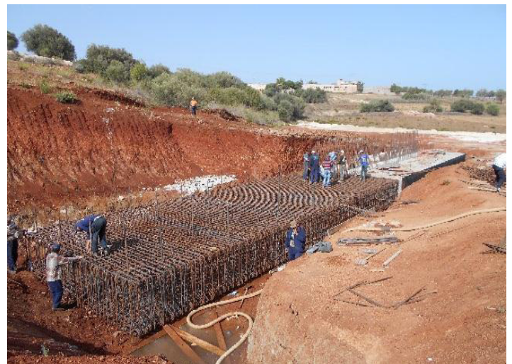
Photo 07 : Mise en place des armatures de la semelle
