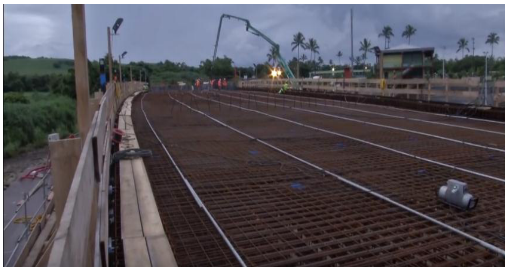
Photo 31 : mise en place du coffrage et ferrailage de la dalle
