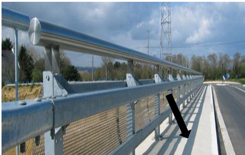
Photo 34 : Exécution des trottoirs
