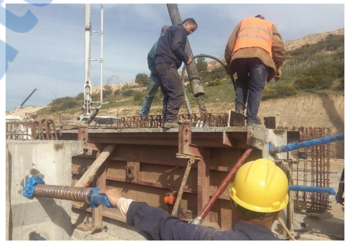
Photo 26 : Coulage de la poutre précontrainte
