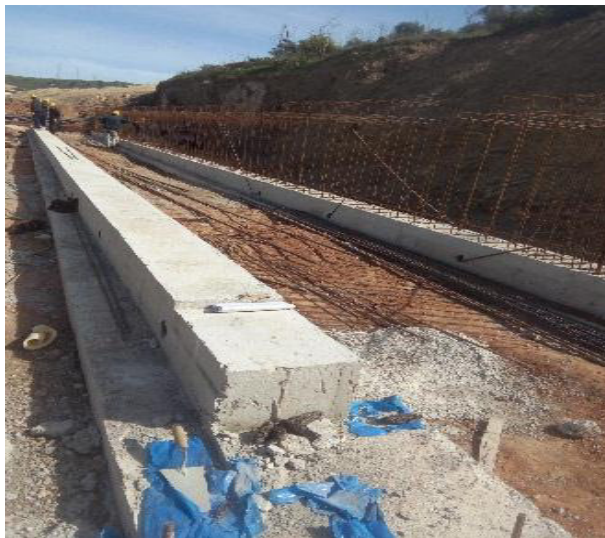
Photo 20 : Réalisation du socle de poutre
