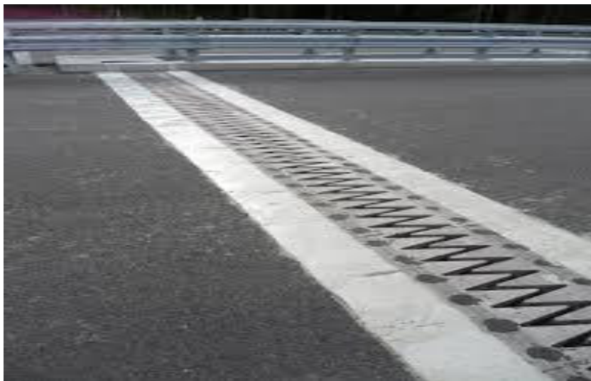
Photo 32 : Pose des joints de chaussée.
