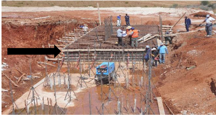
Photo 08 : Coffrage de la semelle
