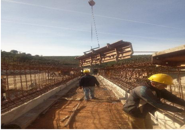
Photo 25 : Pose du coffrage de la poutre précontrainte
