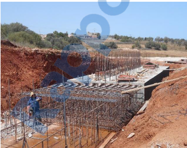
Photo 07 : Mise en place des armatures de la semelle
