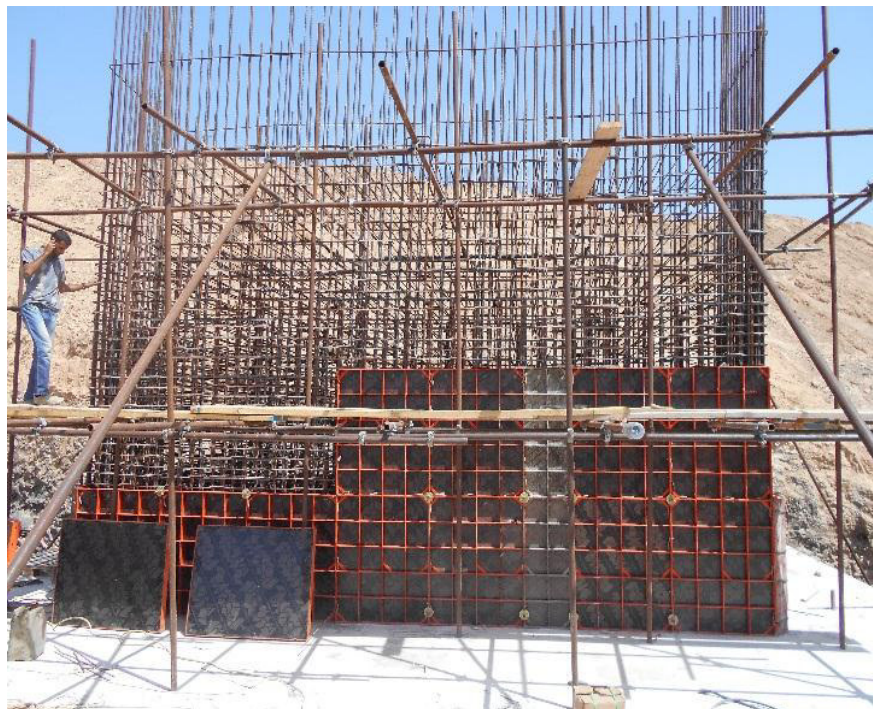
Photo 15 : mise en place des armatures de la pile
