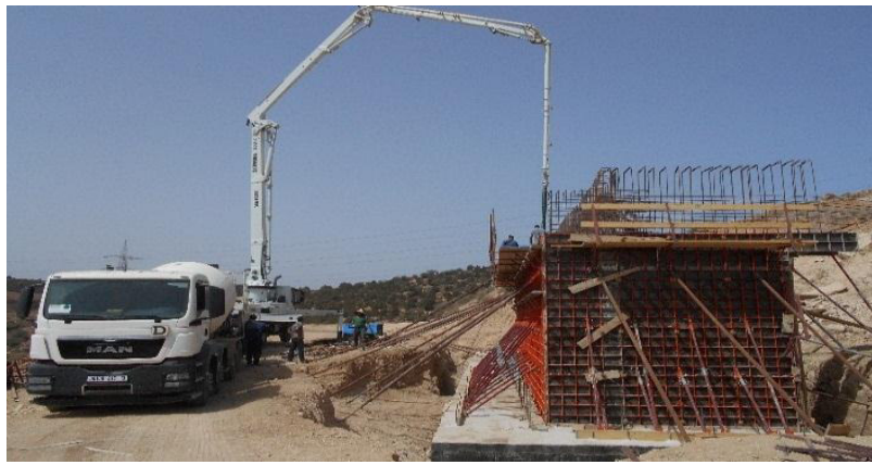
Photo 13 : coulage de la culée
