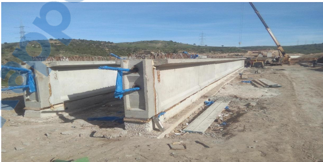
Photo 27 : Poutre précontraintes après décoffrage
