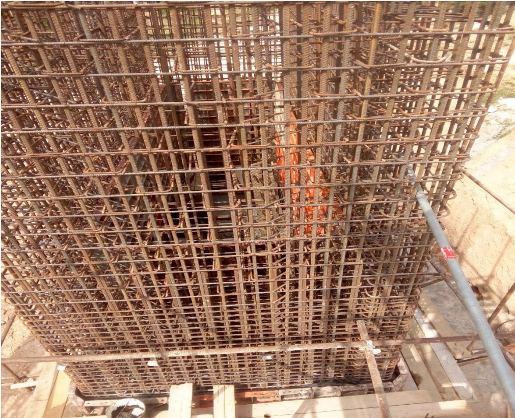
Photo 17 : vue de l'intérieur de la pile évidée
