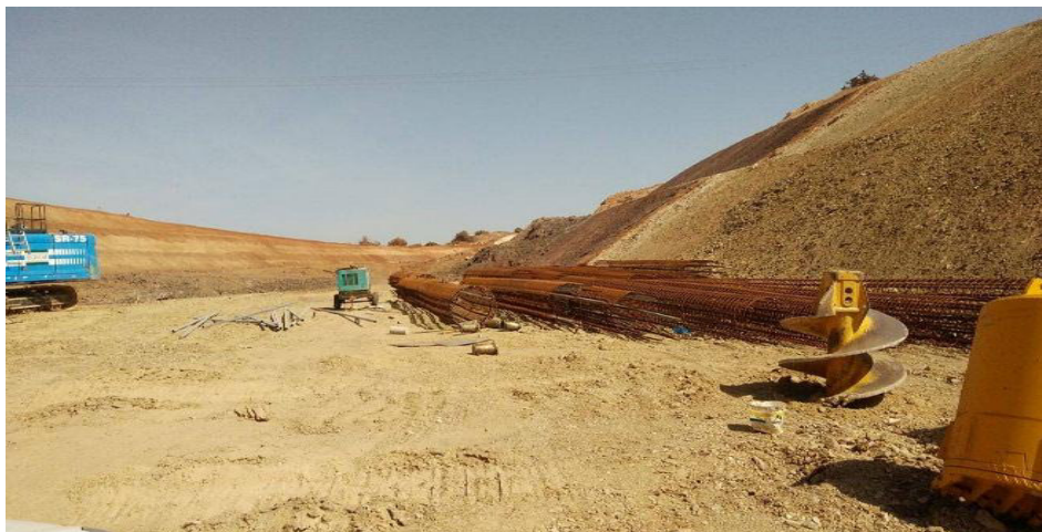
Photo 02 : Ferrailage pour pieux
