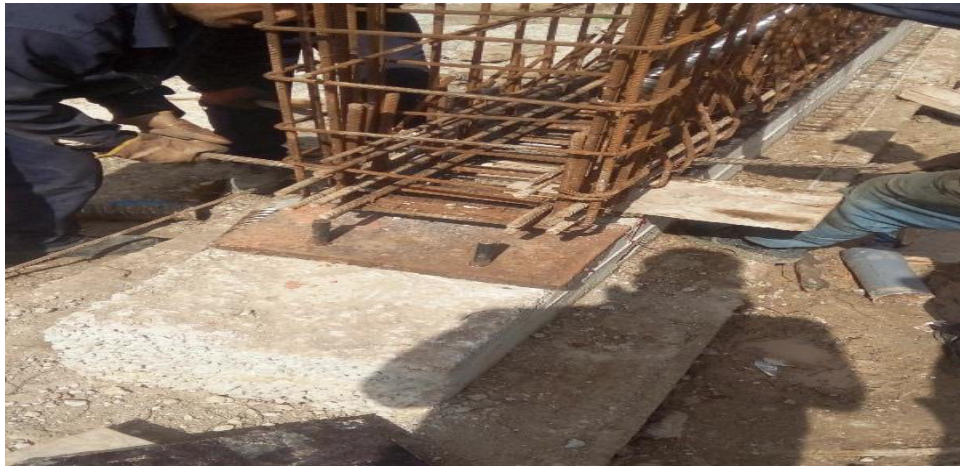
Photo 22 : Pose des socles d'appuis
