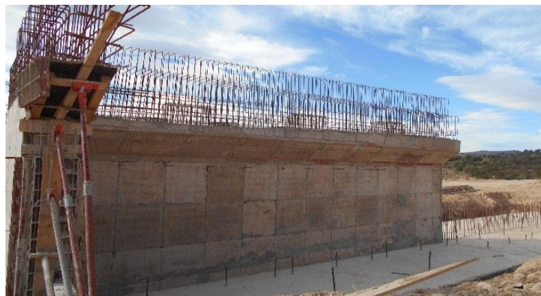
Photo 14 : culée coté GHAZAOUET après décoffrage
