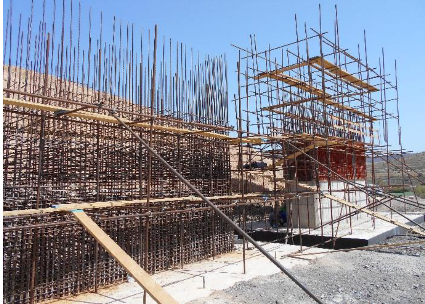
Photo 15 : mise en place des armatures de la pile
