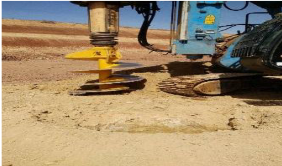
Photo 03 : Forage du pieu
