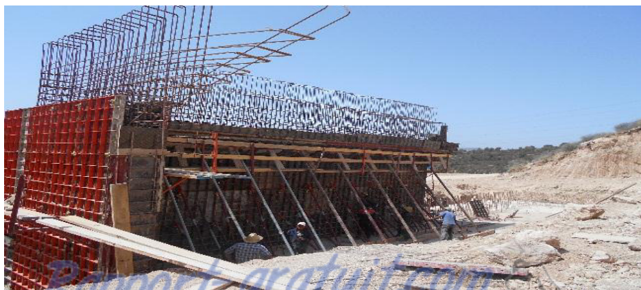
Photo 12 : Coffrage de la culée
