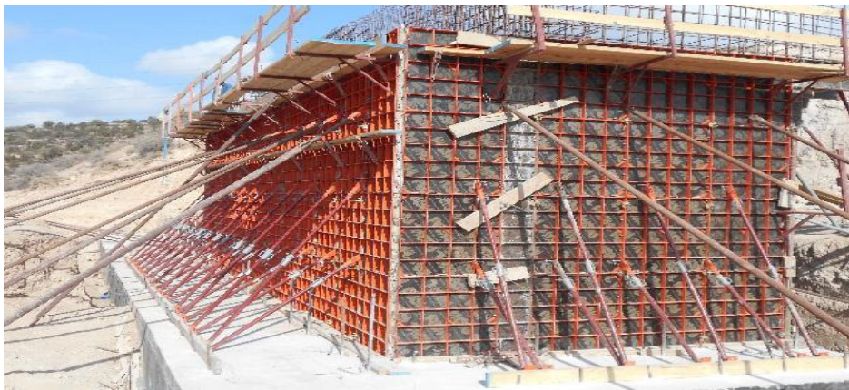
Photo 11 : mise en place du ferrailage de la culée
