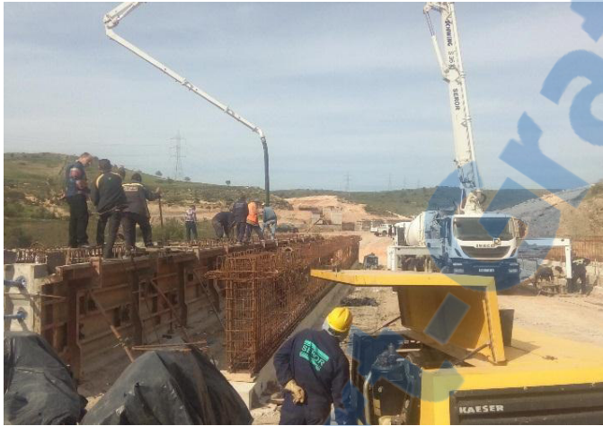
Photo 26 : Coulage de la poutre précontrainte
