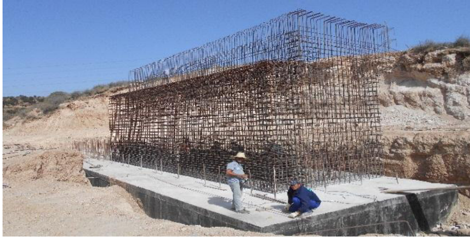
Photo 11 : mise en place du ferrailage de la culée
