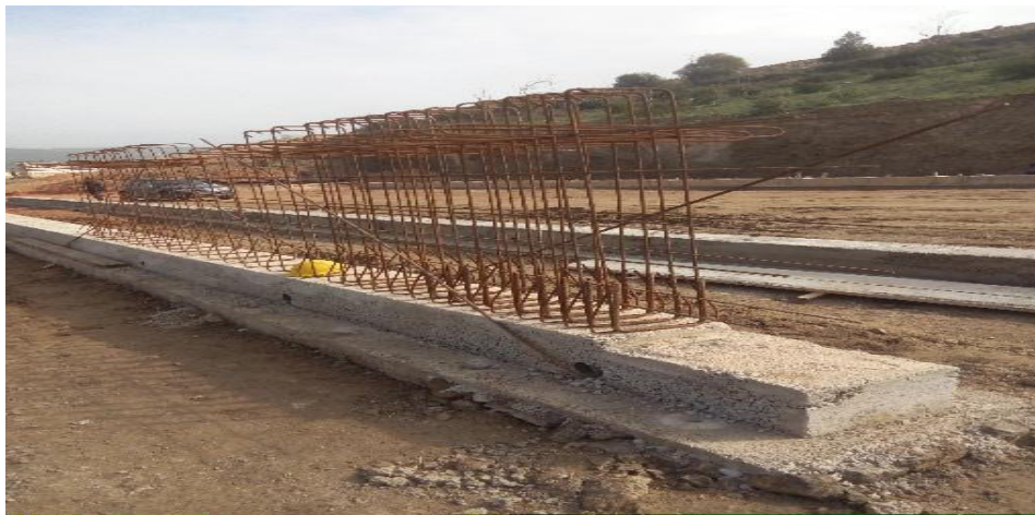
Photo 21 : Mise en place du ferrailage de la poutre précontrainte
