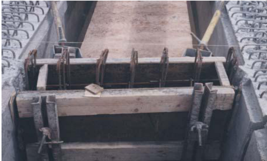
Photo 30 : coffrage des entretoises
