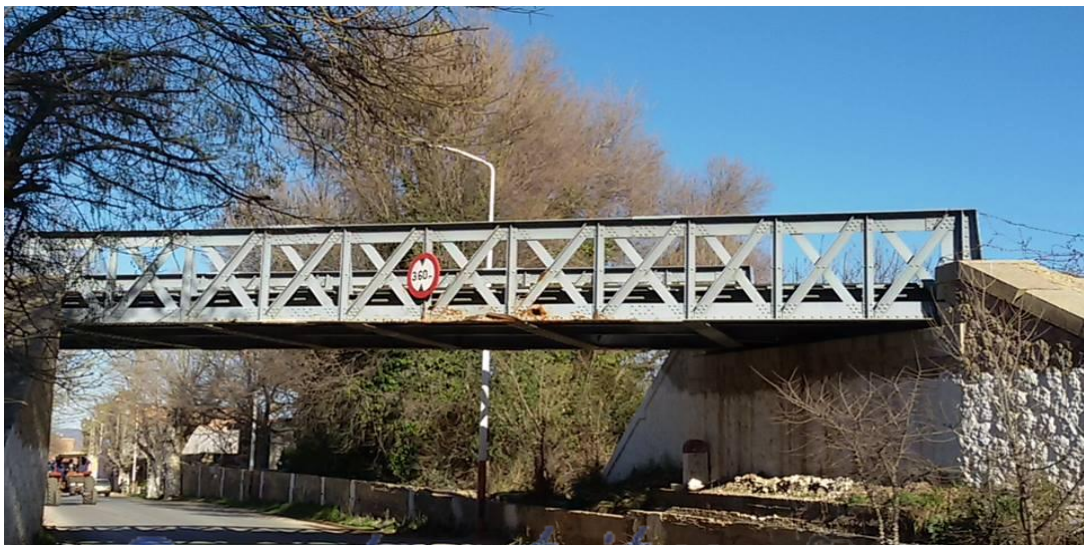
Photo.4.2 Pont vu du côté de Sebdou
