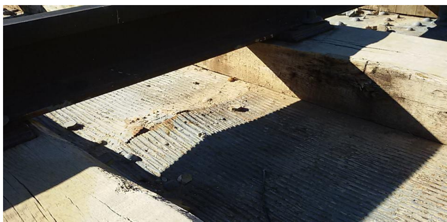
Photo.4.13 Tôle striée déformée du tablier
