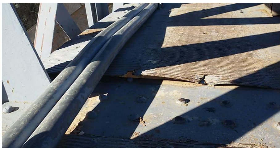
Photo.4.14 Tôle striée arrachée et tuyaux déformés
