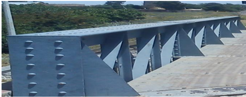
Photo.4.9 Poutre principale vue d'en haut
