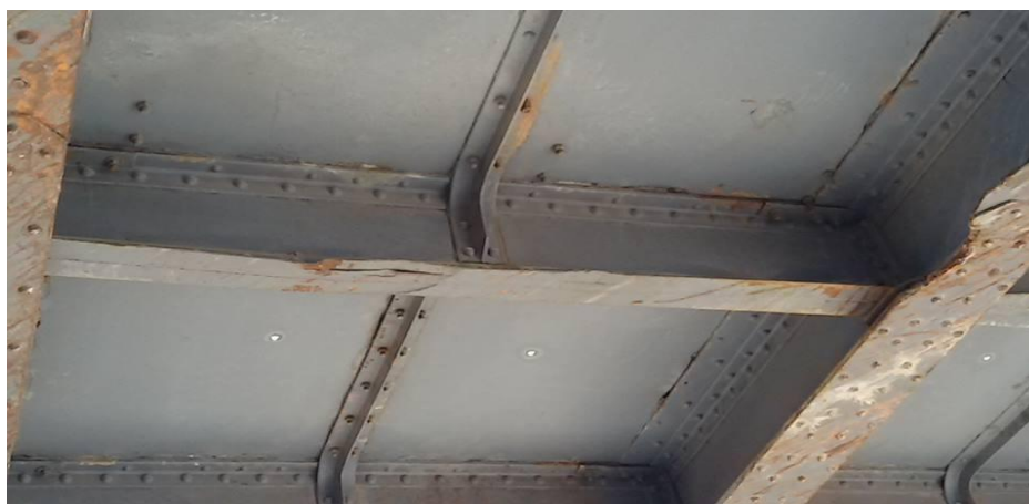
Photo.4.17 Longerons courant 3 en allant vers la gauche du coté de Sebdou
