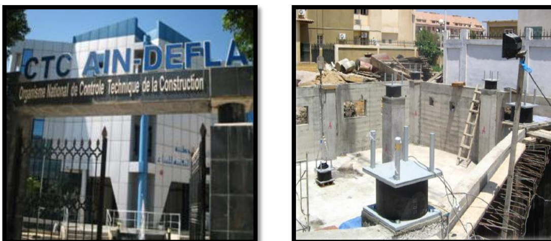
Figure IX.7. Installation des appuis parasismiques à CTC Chlef agence Ain Defla [17].
