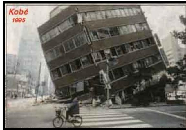
Figure IX.4. Effondrement d'un bâtiment dû au séisme de Kobé.
