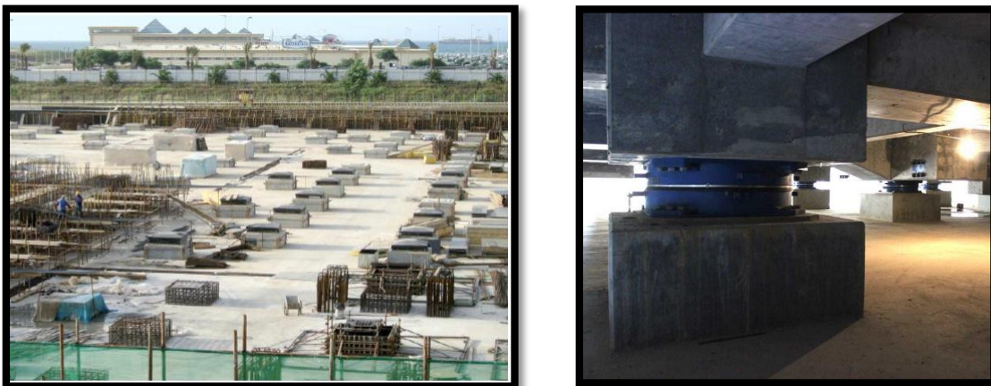
Figure IX.9. Isolation sismique sous la grande mosquée d'Alger [17].
