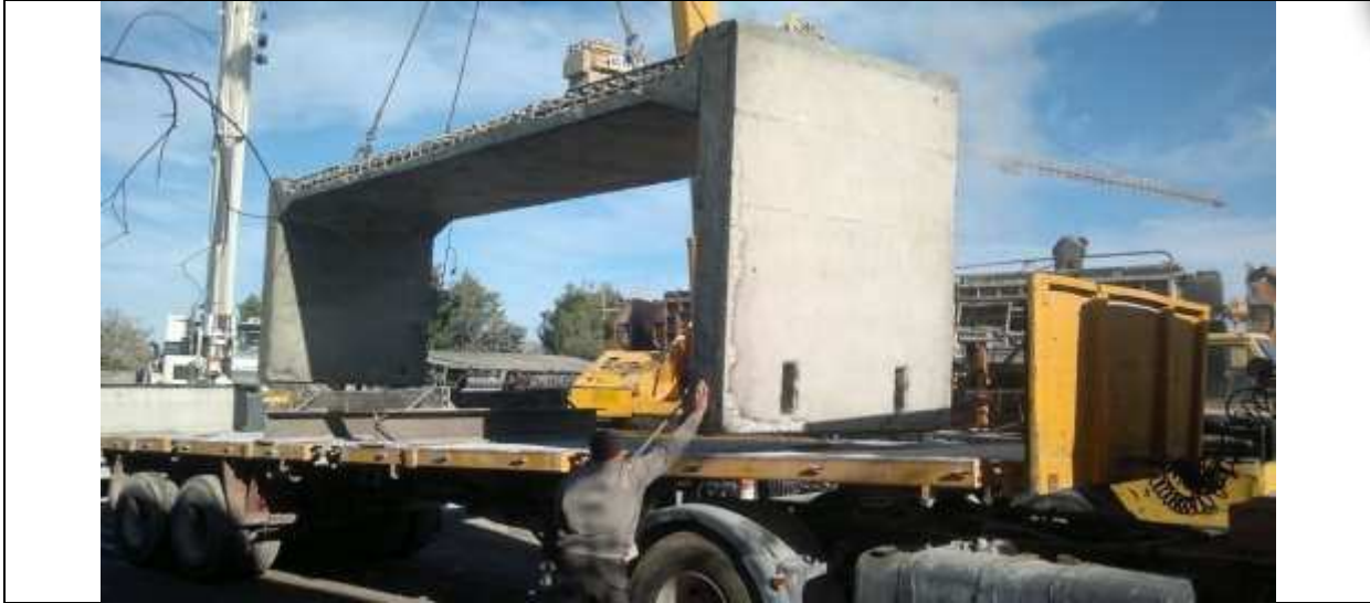
Figure 8 : Manutention d'un élément « U » renversé
