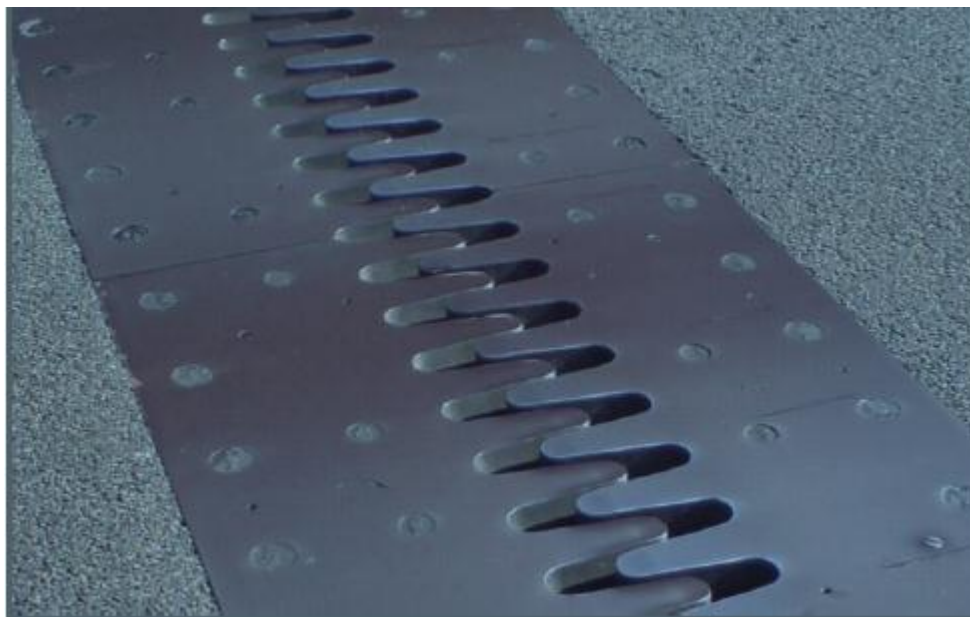
Figure 4.5. Joint à peigne à dents arrondis
