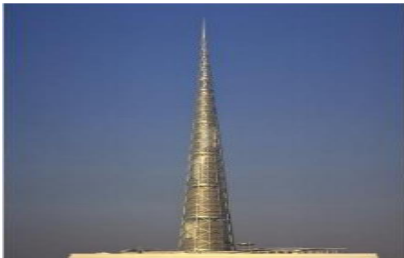
Figure1.10 : Système ALA Millennium Tower-Tokyo.
