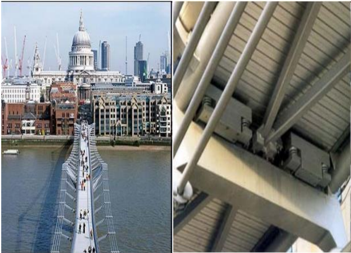
Figure 1.16 : AMAs verticaux installés sous le tablier de la passerelle du Millenium à Londres (Allani, 2015).
