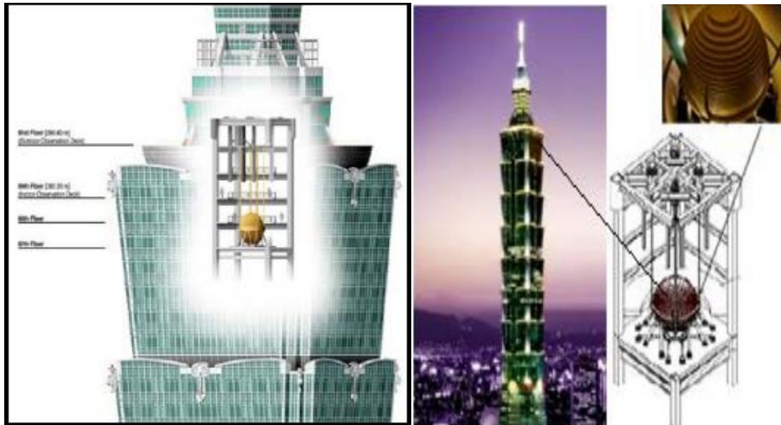
Figure 1.20 : AMA pendulaire installé dans la tour de Taipei (Benzina, 2013)
