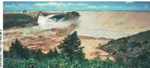
Figure 3.2 : Rupture de barrage de Teton (Bouhlali, 2006)
