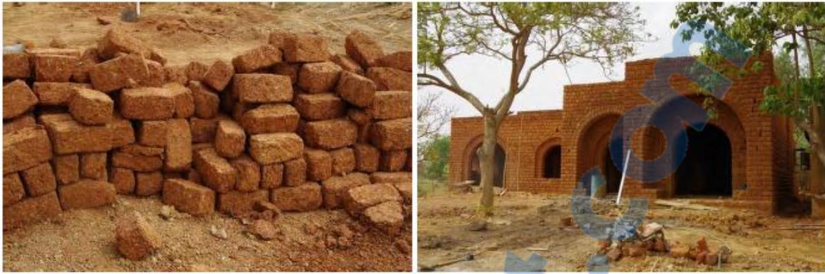
**Figure 1.11** : Construction en blocs découpés, Burkina Faso (Paulus, 2015).
