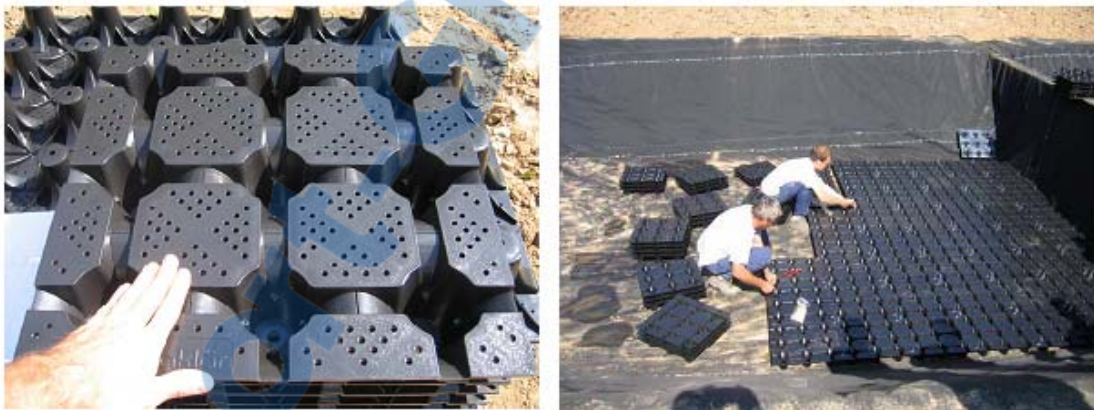
Figure 0.13: Photo de la mise en place d'un planché aérant pour un filtre à écoulement vertical [65].
