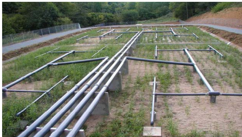
Figure 0.9: Alimentation en surface des filtres verticaux de la Station Saint Laurent (France).
