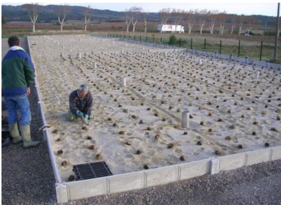
Figure 1.12: Photo prise lors de la plantation des roseaux pour un filtre à écoulement vertical.
