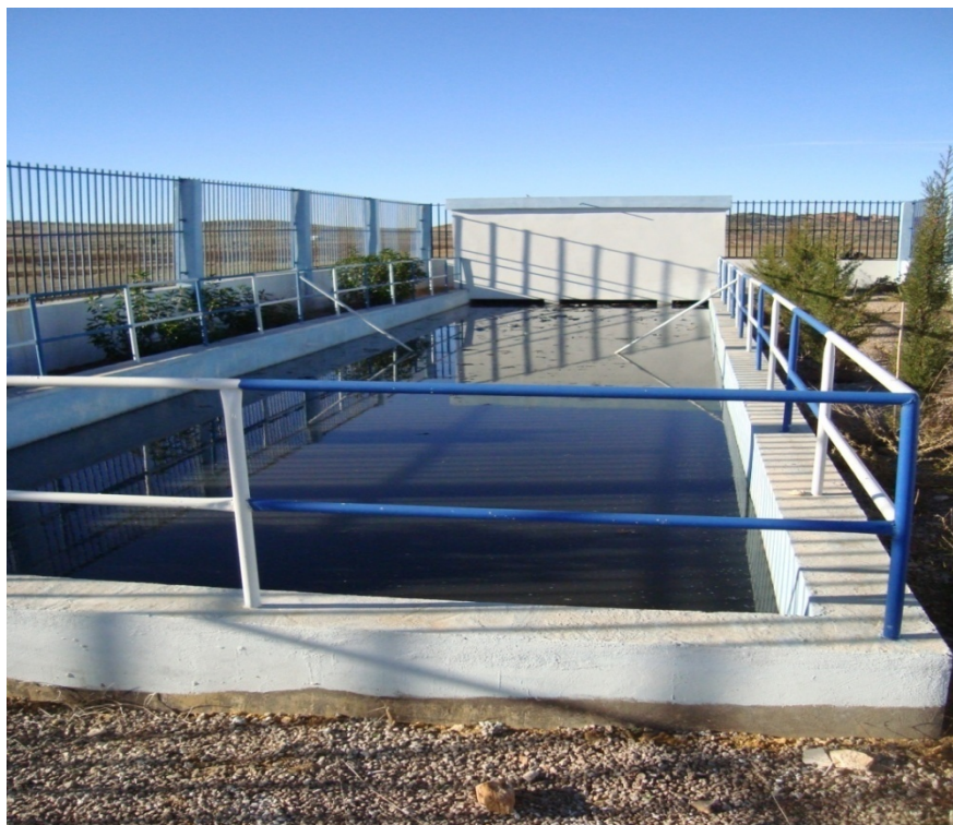
Figure 0.40: Le bassin de décantation Terny.
