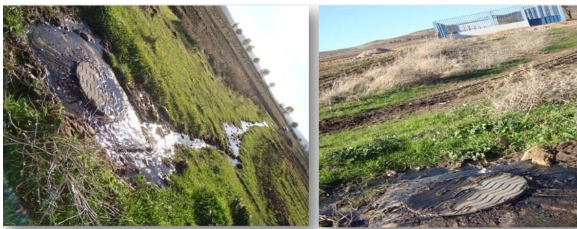
Figure 0.42: Déversement des eaux usées dans les terrains agricoles à l'amont du bassin de décantation de Terny.
