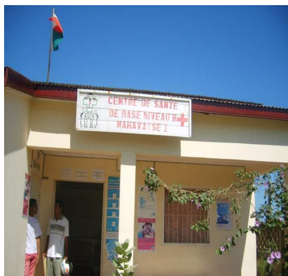
Photo 1 un site de P T M E à Mahavatse
