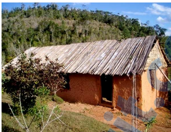
Bambous utilisés comme toiture Source : V. Holiarimino, Tsinjoarivo 2011
