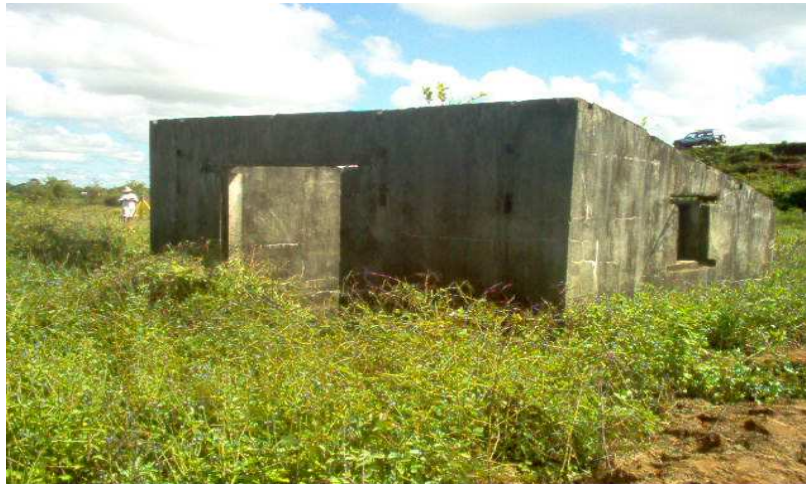
Figure n°3. BATIMENT D'EXPLOITATION EXISTANT
