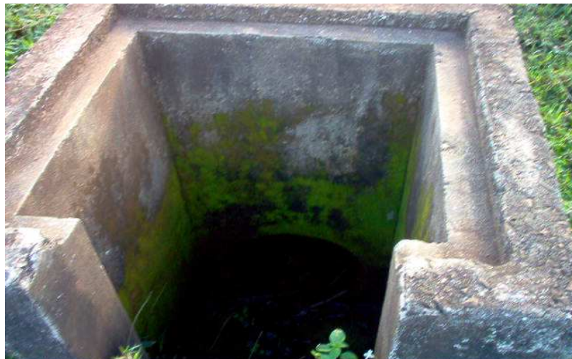
Figure n°6. PUISARD DU SIPHON EXISTANT
