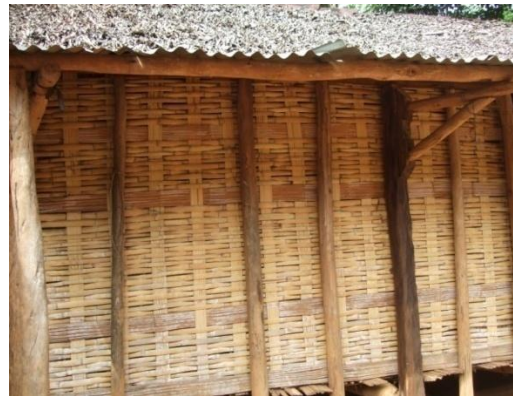
Photo 28: Mur de maison traditionnelle fait en bambou ( Bambusa vulgaris constrictinoda )
