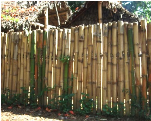
Photo 27: Clôture de maison
