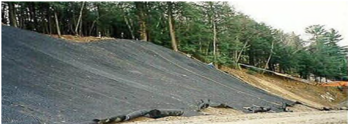
Figure 2.8 – Renforcement par géogrilles. (Boulfoul K.,2005)
