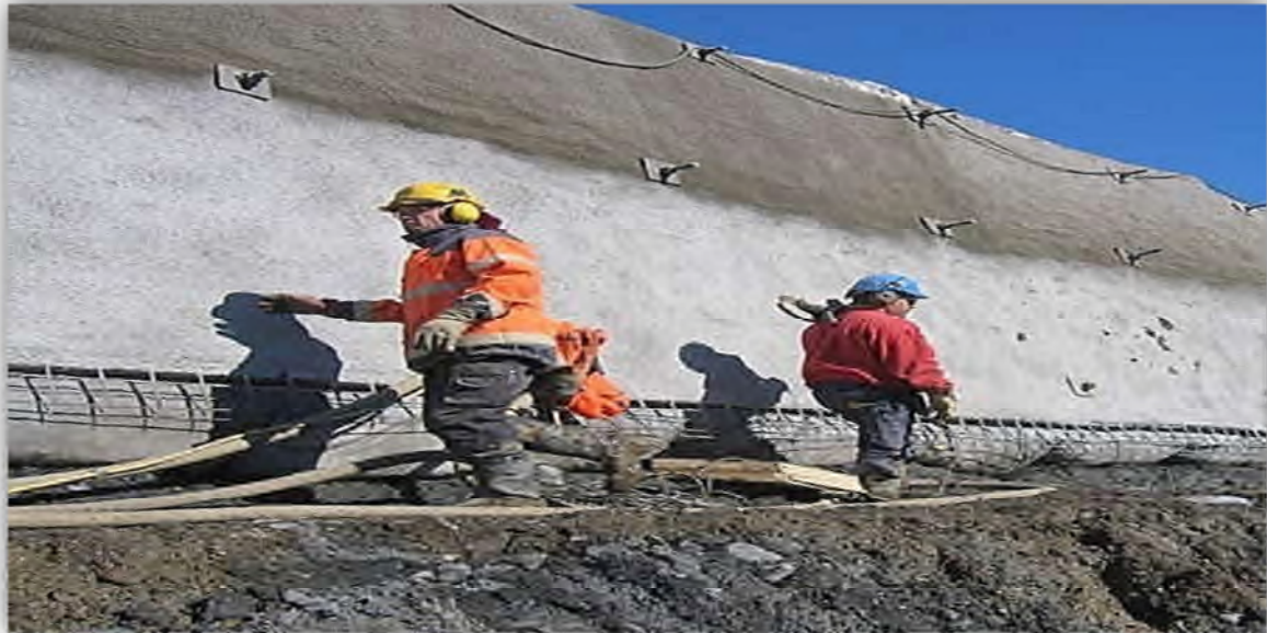
Figure 2.10 – Renforcement par ancrage. (Cartier G.,1986)
