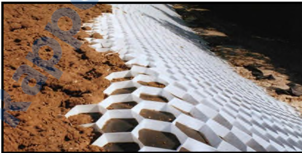
Figure 2.7 – Renforcement par géotextiles (Bouffoul K.,2005)
