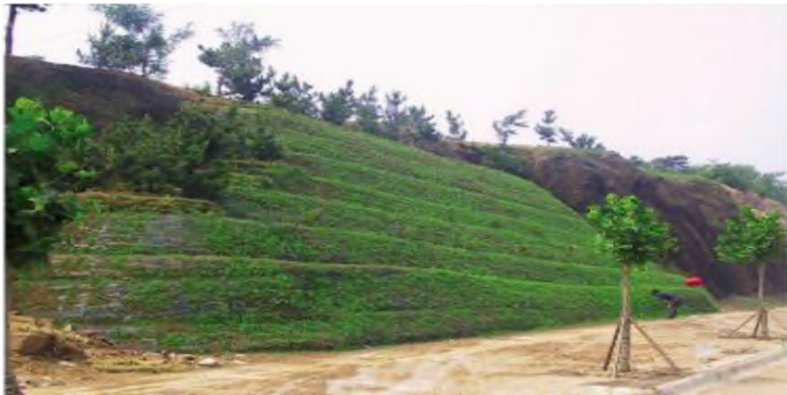
Figure 2.6 – L'implantation des plantes dans un talus.
