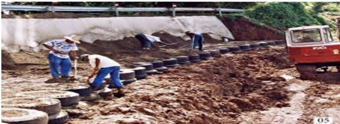
Figure 2.9 – Renforcement par Pneusol. (Bedr S.,2008)
