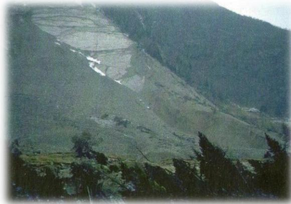
**Figure 2.9.** Glissement en rive gauche du barrage du Vajont (hydropower & dams)
