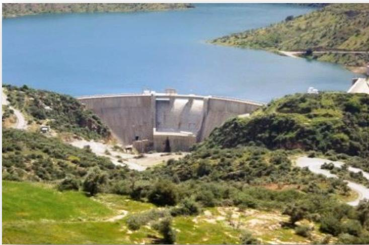
**Figure 2.1.** Barrage voûte de **Tichi Haf Béjaïa** (Algérie) mis en service en 2005. Sa hauteur est de 84 m.
