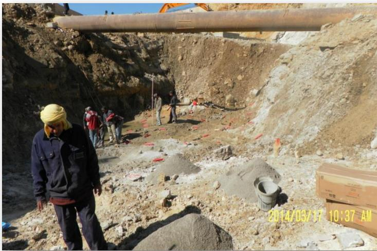
**Figure 4.1.** L'installation de l'explosif sur le chantier de barrage voûte mince d'oued Taht Wilaya de MASCRA.
