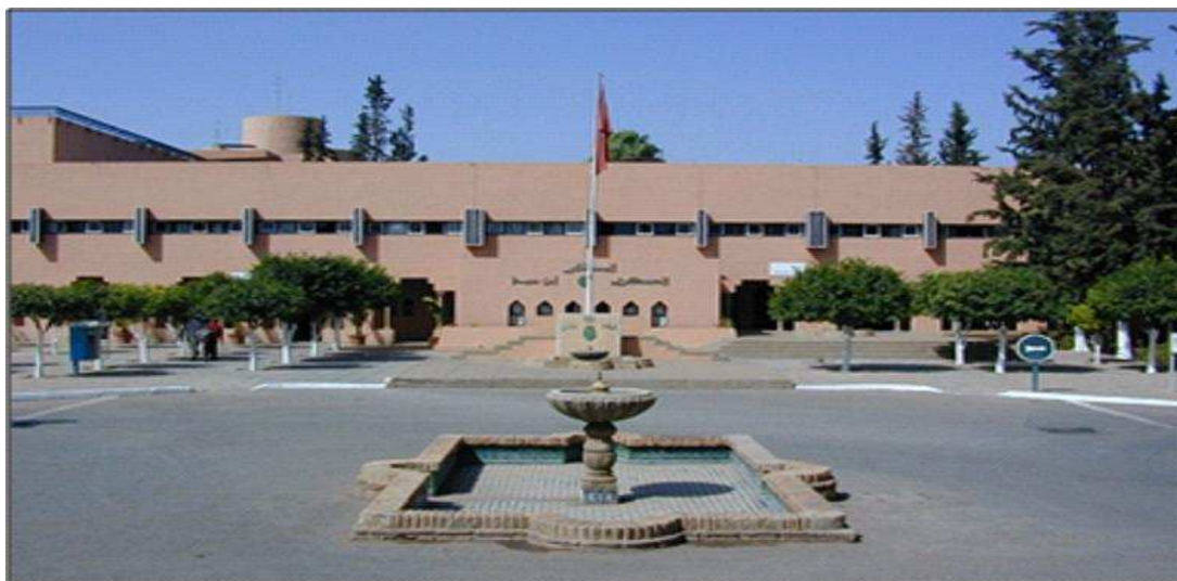
Figure 2: Façade de l'hôpital HMA
