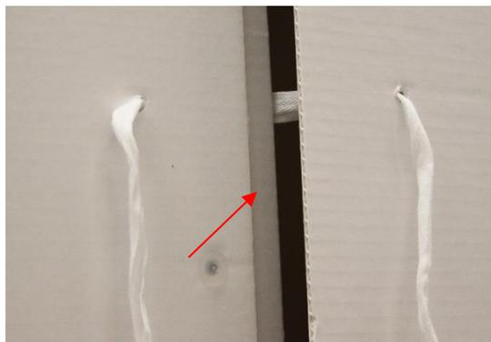
**Fig.164** Vue des volets avec le système de fermeture (ruban de coton) et anti-poussière
