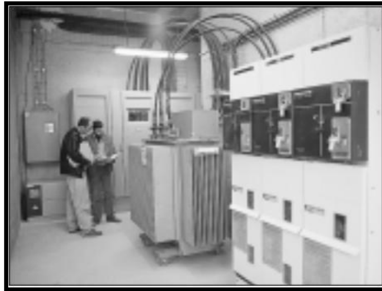
Fig. 26 : Poste d'intérieur HT/BT à comptage BT pour réseau 20 kV
