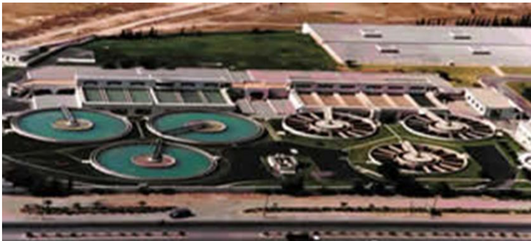
Figure 2 : Station de traitement des eaux d'OUED SEBOU
