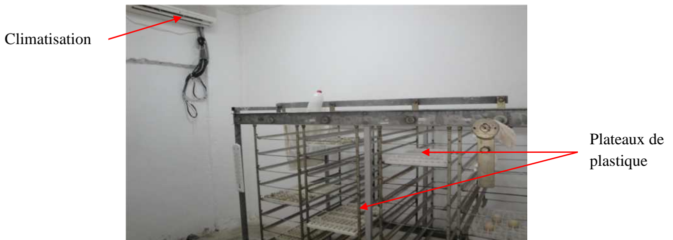
Figure 2: Salle de stockage des œufs au centre cynégétique de Zéralda.
