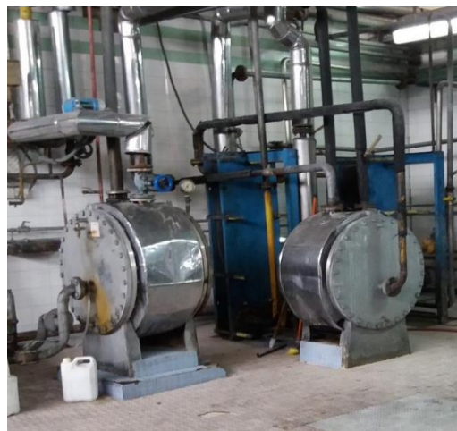
Figure 3: échangeurs tubulaires
