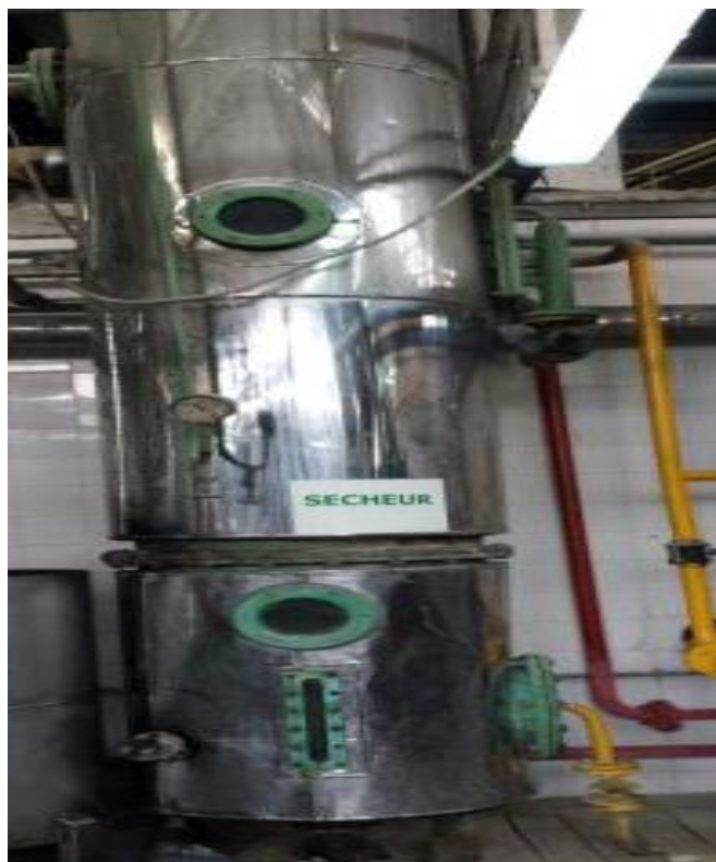
Figure 7: Sécheur sous vide
