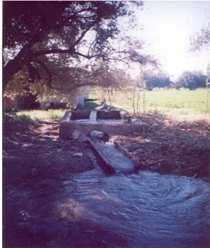
Figure 14 : Bassin en béton pour la réception d'eau pompée
