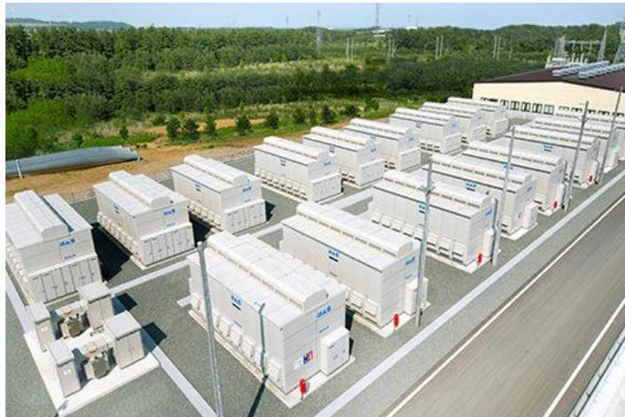
Figure 105: Batteries de 34 MW pour stabiliser une ferme éolienne de 51 MW [41]
