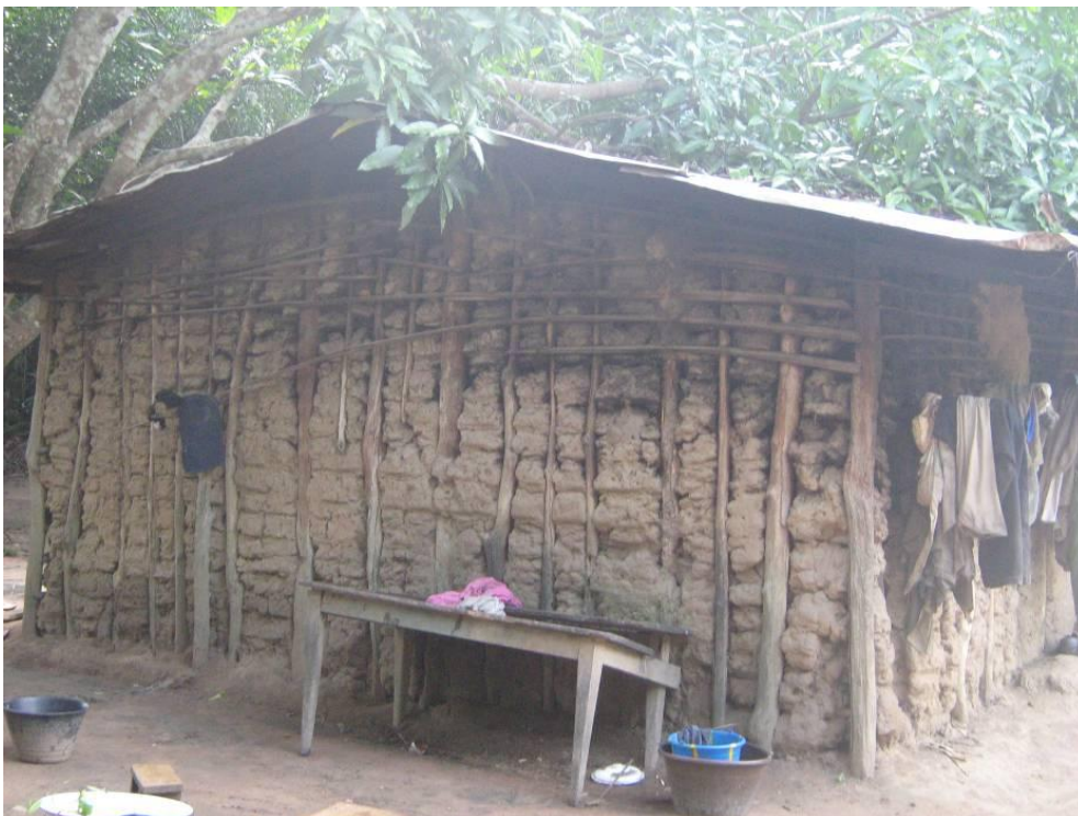
Photo 21 : Case villageoise construite en terre battue et soutenue par des perches de teck à Bafia (Cameroun)
