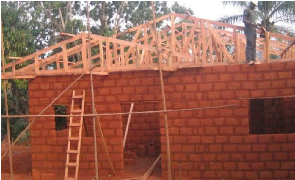
Photo 9 : Lattes utilisées dans la charpente d'une maison dans le village de Felap (Ouest-Cameroun)
