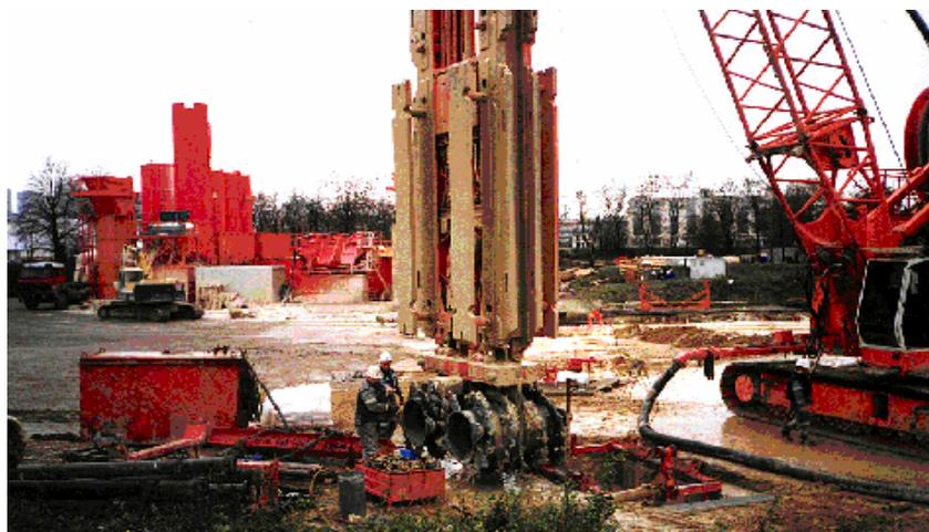
Fig 2.10 Hydrofraise : Excavation d'un Panneau
