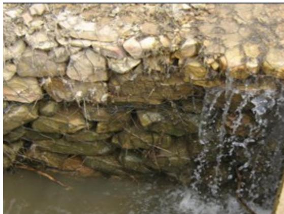
**Photo (1.4) :** Seuils de sédimentation en Gabions et en pierres sèches réalisés dans le bassin Versant du barrage BAKHADDA
