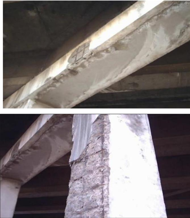
**Photo 2.** *Enrobage en béton insuffisant (front de mer Oran) [LAS, 2008]*
