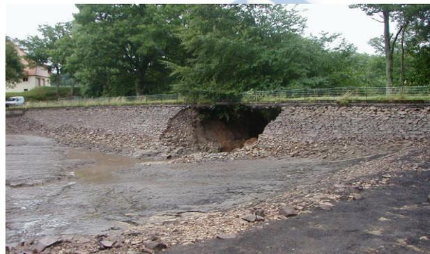
Figure 2.10 : Rupture par érosion interne le long de la conduite de vidange à SAIT-GERVAIS D'Auvergne le 15 janvier 2001 (poly-de-Dome) photo CEMAGREF Aix-en – provence
