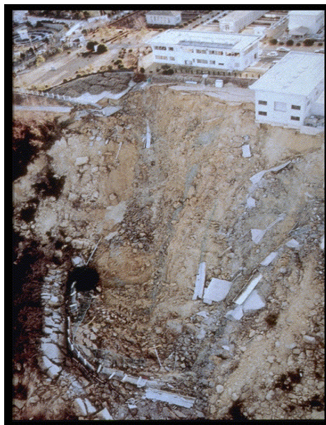
Figure 1.5: Séisme de Kobé (japon), 1995 (document NISEE- USA)
