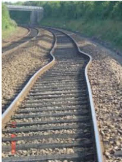
Figure 2 : Flambement de deux poutre long
