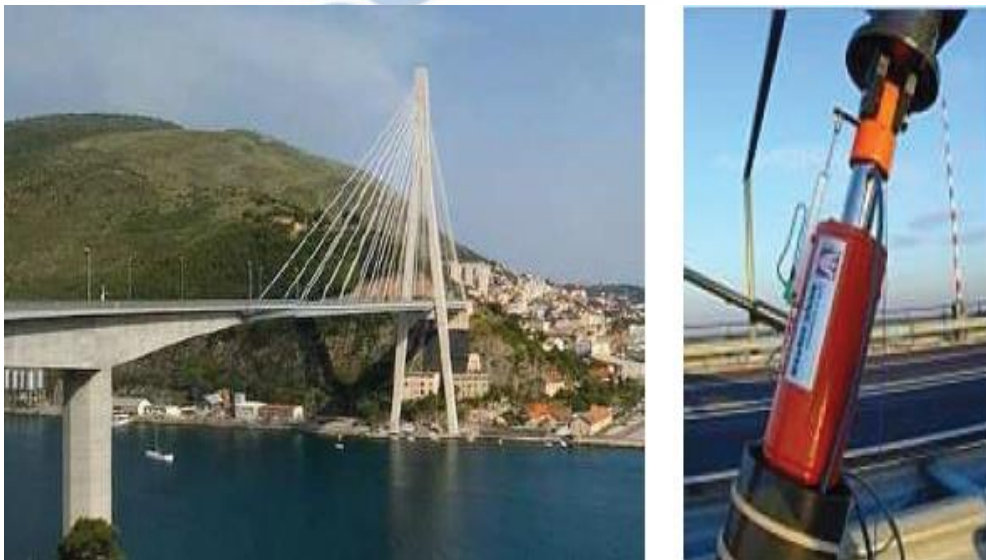
Photo 2.10 Installation d'un amortisseur MR sur un pont à haubans en Croatie.
