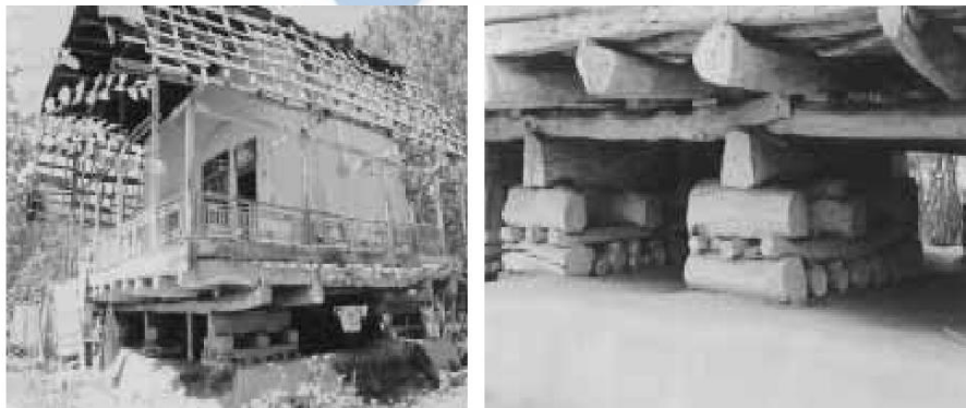
Photo 2.1 Isolation à la base par les pièces de bois en Lanhijan, nord d'Iran [25].
