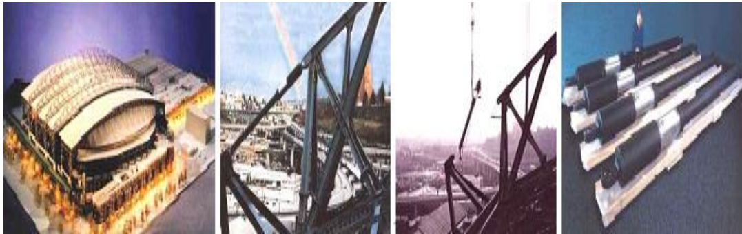
Photo 2.5 Amortisseur à fluide visqueux installé sur new pacific northwest baseball park.
