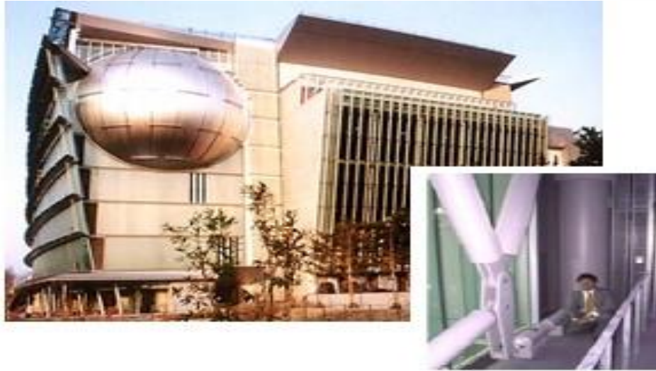
Photo 2.9 Installation d'un amortisseur MR sur le musée nationale de Tokyo.
