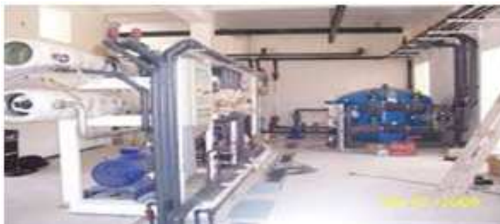
Figure 3 : ouvrages hydrauliques et industriels
