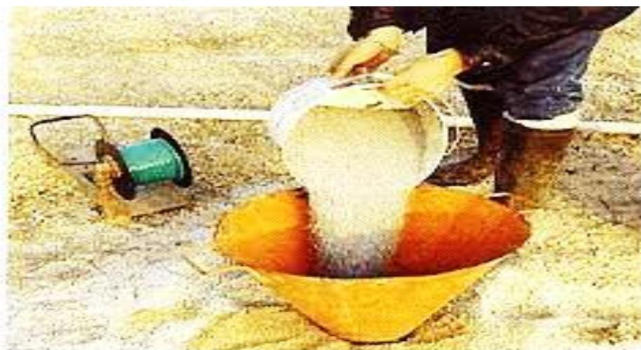
*Figure 12:le remplissage des trous de foration avec de l'Ammonix*
