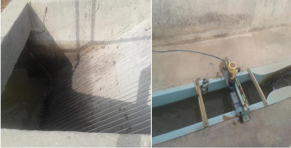
**Image 6 :** Ouvrage d'arrivé (Déssableur et mesure de débit)
