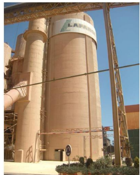
Figure 8 : silo d'homogénéisation
