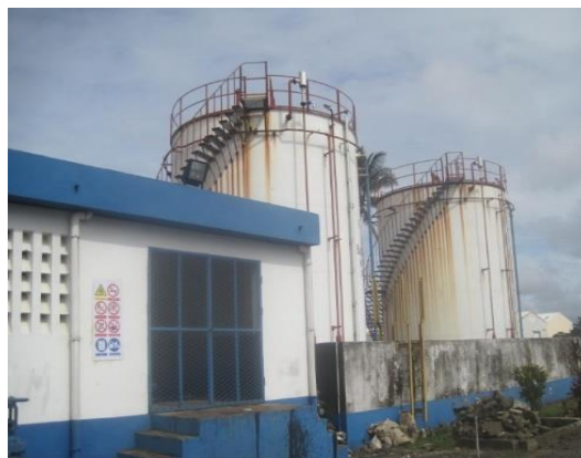
Figure 20 : Photographie de la salle de récepteur du fuel et les deux citernes pour les stockages
