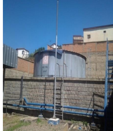
Figure 12 : Stockage du Fuel (Prise dans la centrale thermique à Mandroseza)
