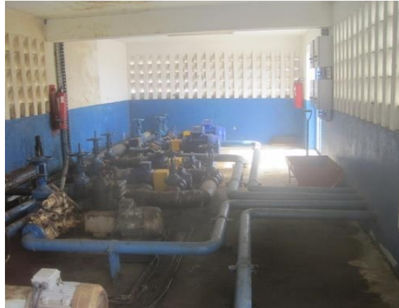
Figure 21 : Photographie des tuyaux de cheminement du fuel
