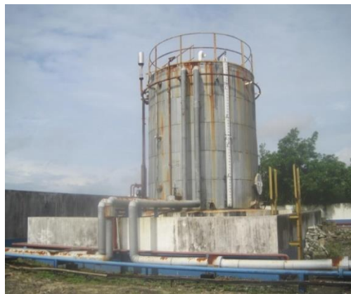
Figure 22 : Photographie de la caisse de décantation
