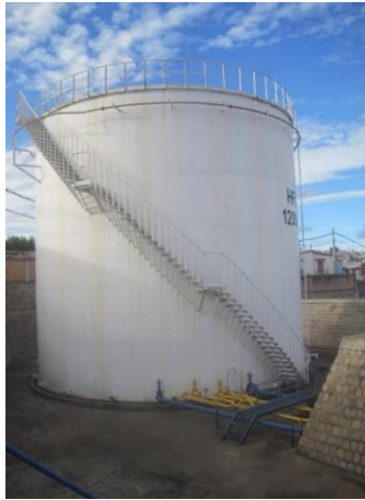
Figure 12 : Stockage du Fuel (Prise dans la centrale thermique à Mandroseza)
