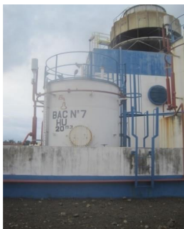
Figure 25 : Photographie de la citerne pour le stockage du déchet de fuel
