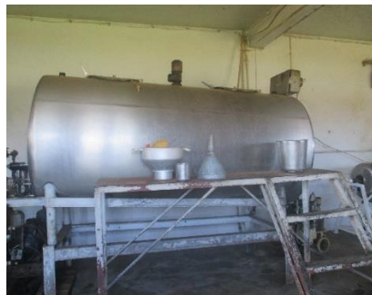
Photo 6: Tank à lait 2500 Litres
