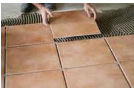
Pose des carreaux
