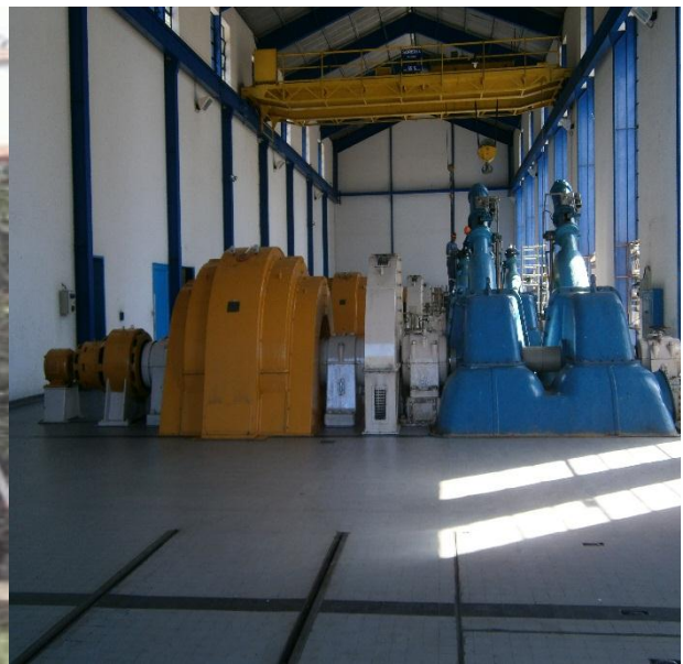
Figure 6 : Salle de machine de la centrale
