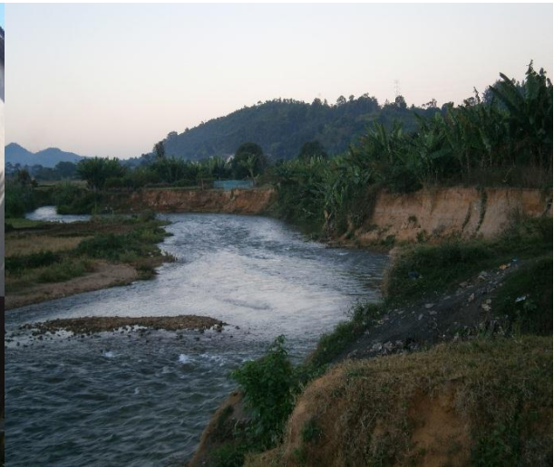
Erosion à 400 m en aval restitution de la centrale
