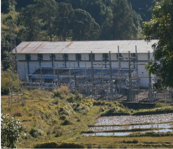
La centrale hydroélectrique
