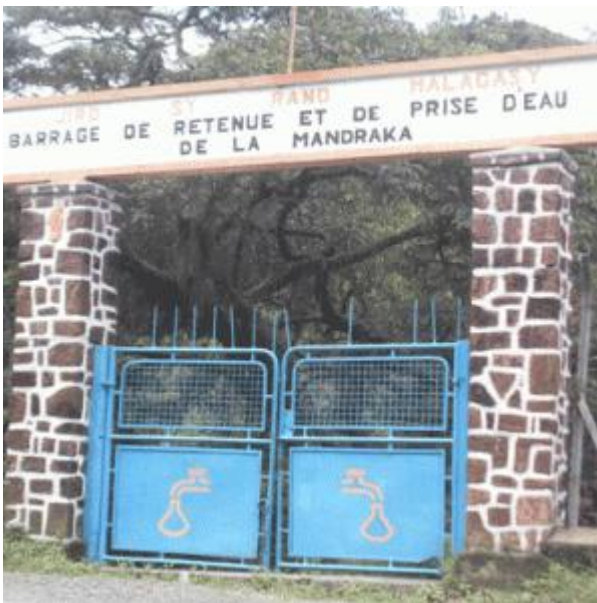
Figure 5 : voie d'accès du barrage de retenue
