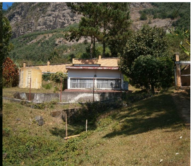
Figure 8 : Station de traitement d'eau
