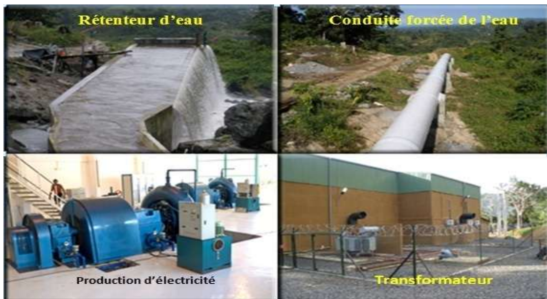
Figure 15 : Différents parties d'un barrage hydraulique Source : Ministère de l'énergie et de l'hydrocarbure, 2018
