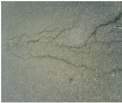
PHOTO n°4 : Fissure longitudinale
