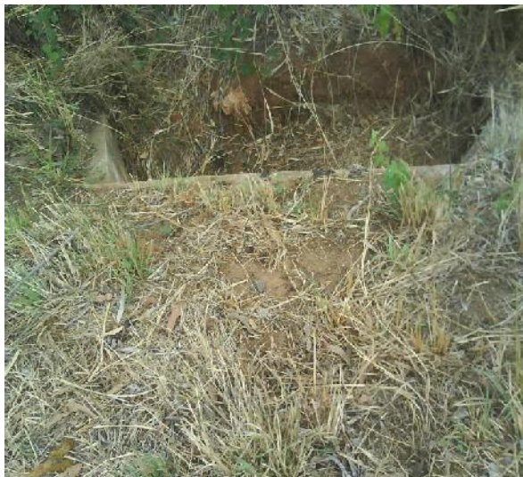
Photo n°3 : Buse envahie par la végétation
