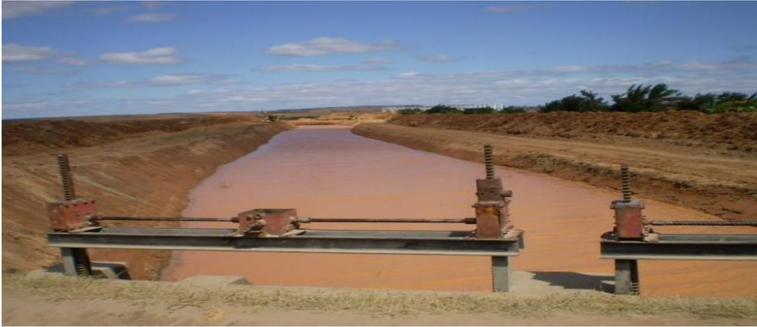
Photo n°3 : Ouvrage de prise et vanne après curage
