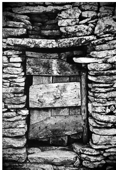
Fig. 40 - Borie ancienne de construction soignée. La porte est montée sur pivot qui tourne dans des trous de dalles avancées ; le linteau, trop faible, est rompu.
