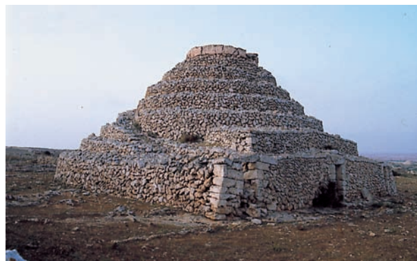
Fig. 32 - Barraca près de Ciutadella (Minorque). Des rampes donnent accès aux gradins. Au sommet est aménagée une plateforme d'observation.
