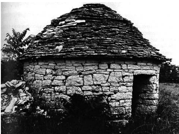
Fig. 36 - Kazum en Istrie (Yougoslavie). Belle construction avec couverture en lauses formant corniche.
