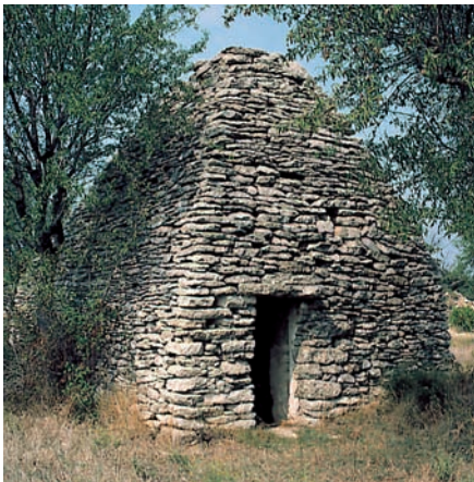
Fig. 21 - Borie près de l'Isle-sur-Sorgue (Vaucluse). Construction sur base carrée qui implique, pour la réalisation de la coupole conique, la pose de grandes dalles dans les angles droits de la base.
