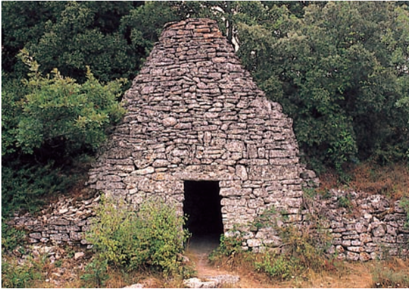
Fig. 19 - Auribeau (Vaucluse). Borie. construction à coupole conique.
