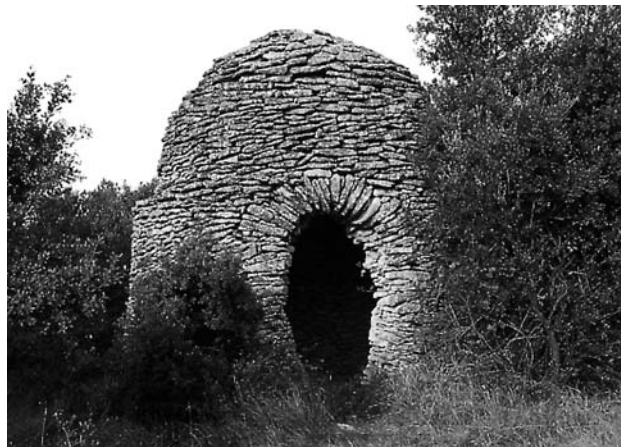
Fig. 38 - Borie à Bonnieux (Lubéron). Entrée ogivale originale qui a permis d'utiliser des pierres plates pour les jambages et le linteau, la courbure assurant une grande résistance.
