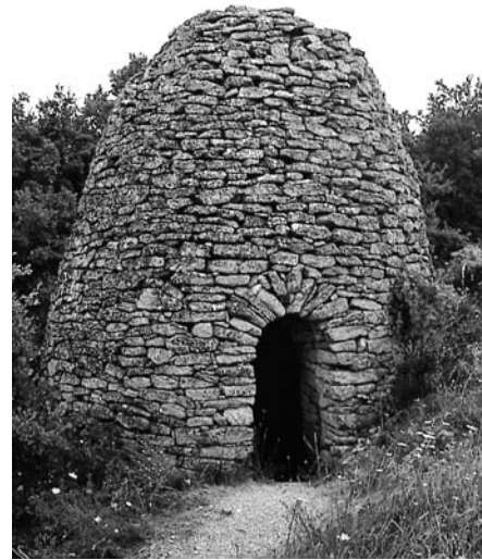
Fig. 42 - Borie à Bonnieux (Vaucluse). Bonne construction, à l'exception de l'arc un peu sommaire sur l'ouverture.
