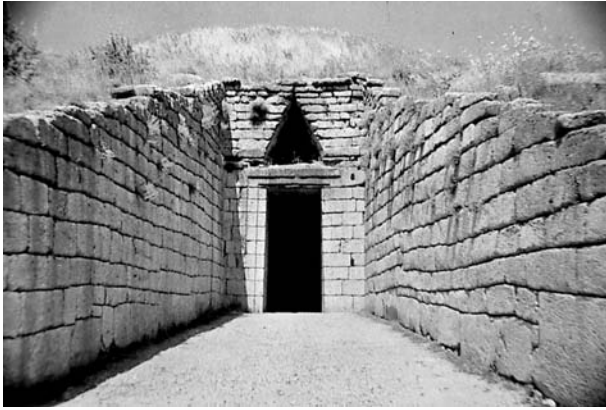
Fig. 50 - Tombeau d'Agamemnon à Mycènes. Le couloir d'entrée (dromos) de 6 m de large et 36 m de long est bordé de murs cyclopéens.
