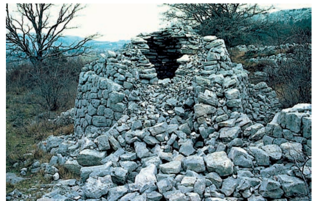
Fig. 26 - La Malle (Alpes-Maritimes). Borie construite à doubles parois séparées, remplissage intérieur par des déchets de pierre (mitraille) ayant entraîné l'éventrement.
