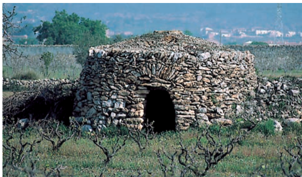
Fig. 27 - Borie de Catalogne (Espagne). Construction quelconque, les pierres n'ayant pas été posées en lits successifs sensiblement horizontaux.
