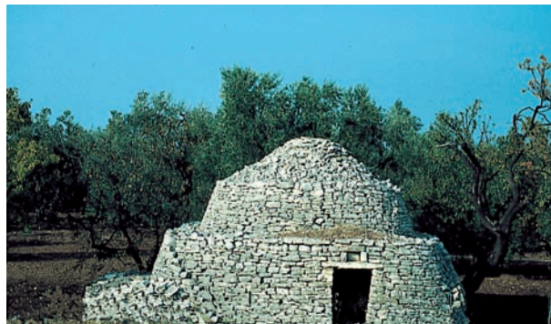
Fig. 31 - Borie dans les Pouilles (Italie). Construction soignée en gradins.
