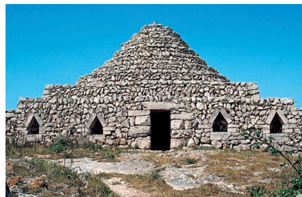
Fig. 33 - Barraca Ses Arenetes (Minorque). Belle construction à 10 gradins et 4 niches en façade.
