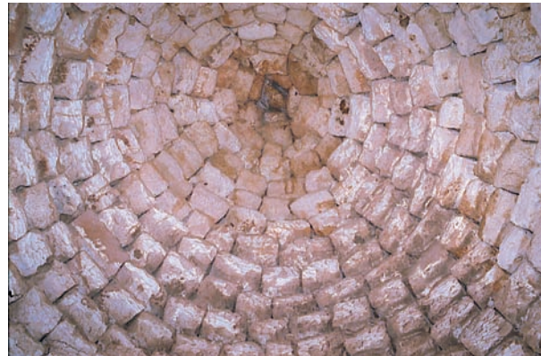
Fig. 34 - Voûte de la barraca Ses Arenetes. Les lits de pierres horizontaux sont parfaitement assisés et bloqués. Le débord des pierres est sensiblement égal à leur épaisseur.
