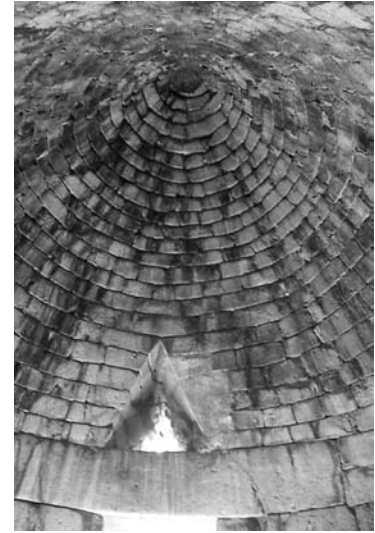
Fig. 51 - Tombeau d'Agamemnon à Mycènes. Vue intérieure de la coupole (la tholos). On observe le grand linteau (120 t), le triangle de décharge et la maçonnerie de pierres parfaitement assisées et ajustées.
