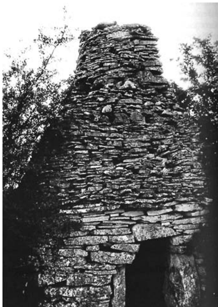
Fig. 35 - Kazum en Istrie (Yougoslavie). Construction sommaire, très haute, avec poste d'observation. Le manque de grandes pierres plates a contraint à un bricolage du linteau !
