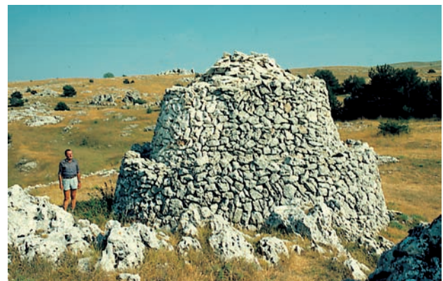
Fig. 25 - Caussols (Alpes-Maritimes). Borie en gradins, belle construction.
